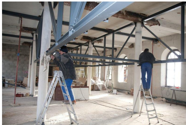
Fig. II.16. Vue sur les travaux de structure des lofts. [31]
