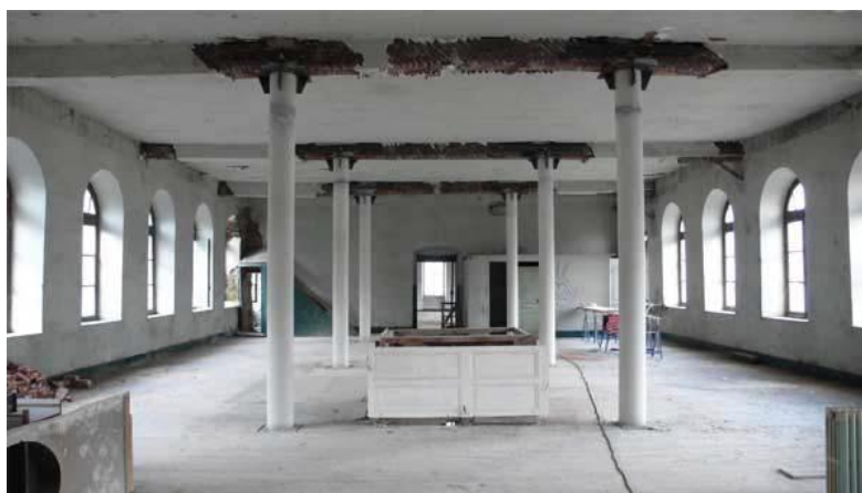
Fig. II.15. Vue sur la nouvelle structure mise en place [31]
