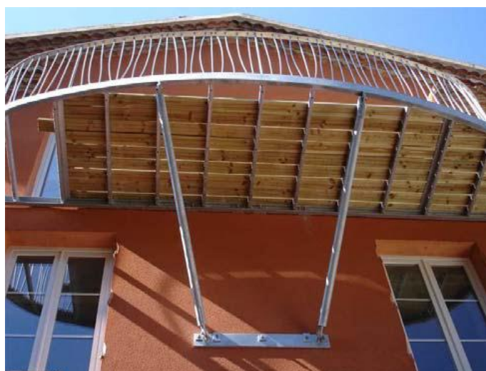
Fig. II.13. Vue sur un balcon inséré à deuxième étage du bâtiment C [31]
