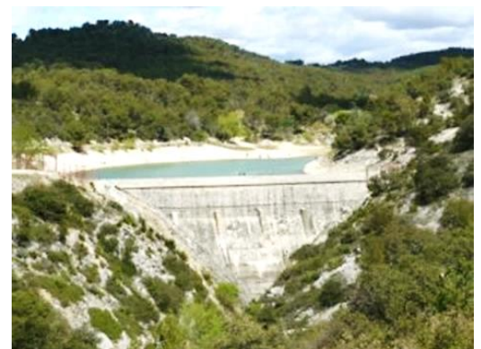
Fig I. 56: Vue générale sur le barrage de Caromb-Paty
