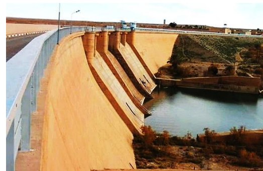
Fig I. 36 : Barrage de Djorf Torba à Béchar
