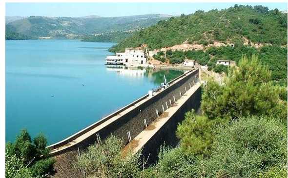
Fig I. 44 : Barrage en enrochements du Hamiz à Boumerdès
