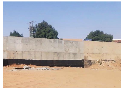
Fig.III. 35 ; la protection actuelle des berges de l'Oued M'ZI
