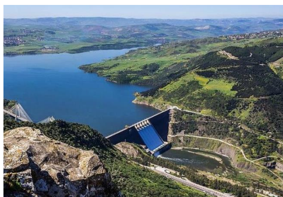
Fig I. 33 : Barrage de Beni Haroun « Le plus grand barrage en Algérie »
