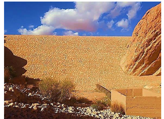
Fig.II. 16: Barrage de Milok
