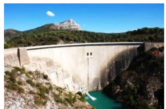
Fig I. 47: Vue générale sur le barrage de Bimont
