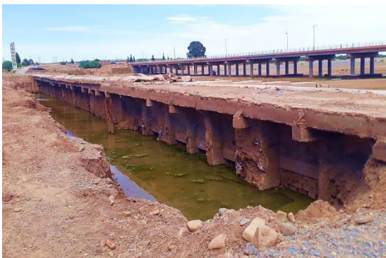
Fig.III. 7 : Vue sur la partie souterraine du barrage de Tadjmout
