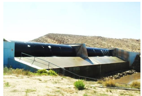
Fig.II. 40: Barrage de Kheneg Sidi Brahim
