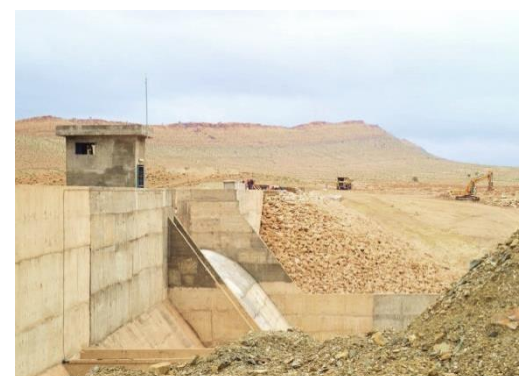
Fig.II. 42: Barrage de Chergui
