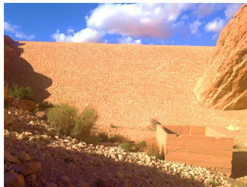
Fig.III. 21 : Vue de face du barrage de Milok
