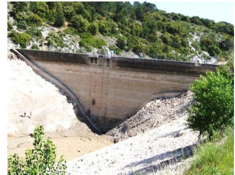
Fig I. 60 : Travaux de contrôle du barrage Source : https://mapio.net/pic/p-11167507/ , consulté 02/07/2021.
