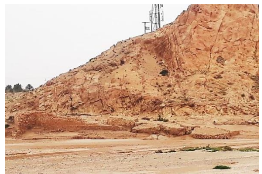
Fig.II. 13: Ruine du barrage de MARGHEURITTE
