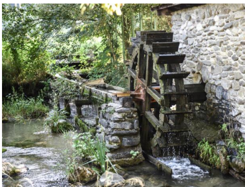
Fig I. 23 : Moulin à eau
