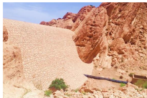
Fig.III. 22 : Vue générale du barrage de Milok
