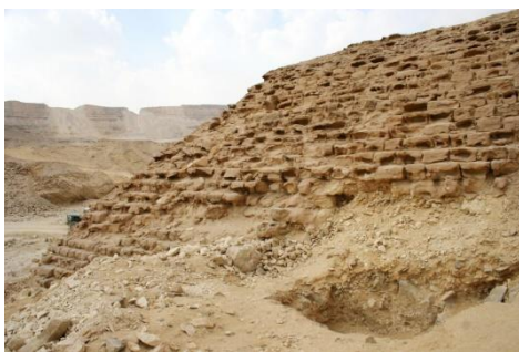
Fig I. 25 : Barrage de Sadd el-Kafara
