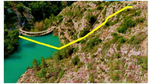
Fig I. 50: La conduite de dérivation créée dans le barrage de Bimont
