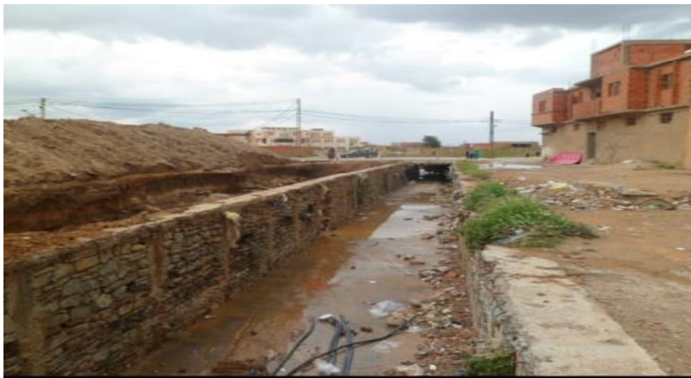
Figure IV.4 : Vue sur l'oued avant son aménagement
