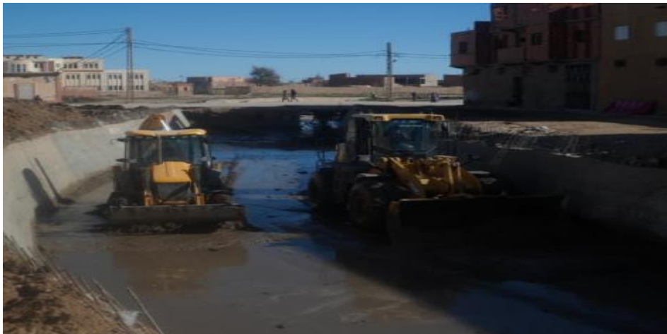
Figure IV.12 : Oued Medssous durant le nettoyage du lit mineur
