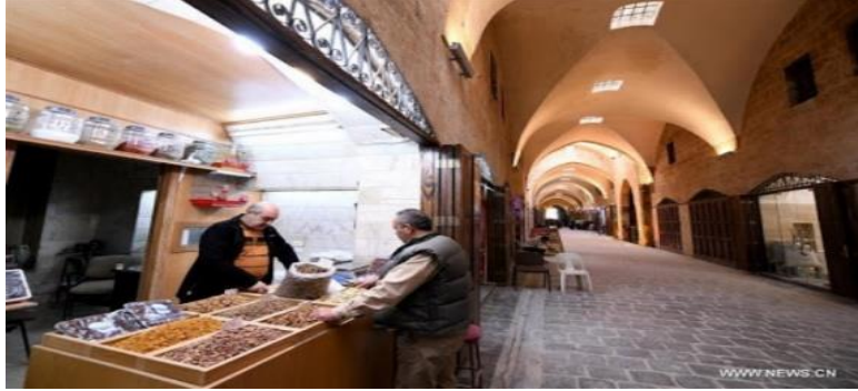
صورة رقم (1-1) بعد بناء الأحجار التاريخية المتضررة في الواجهات وإعادة تدعيمها 24
