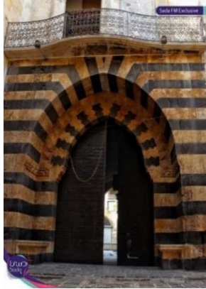
صورة رقم (4-1) تركيب أبواب الخشبية التي تتلائم مع الطراز العمراني الذي أسس عليه السوق
