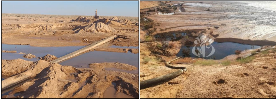
Figure 1.3 Exemple les fuites en Algérie qui ont eu lieu le 3 septembre 2020.
