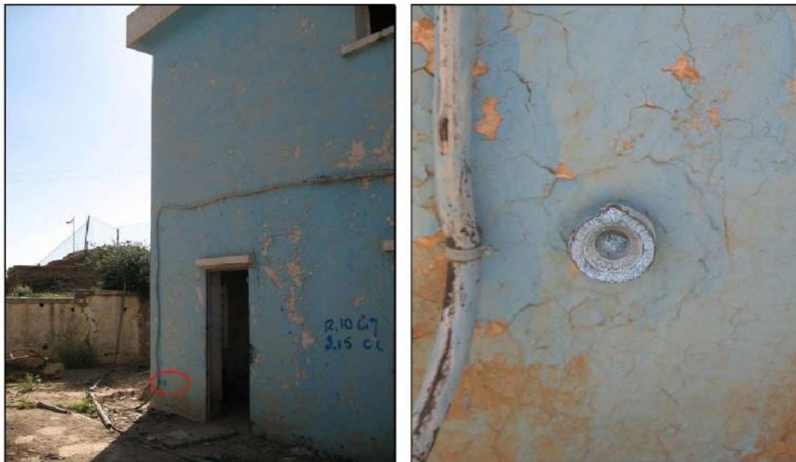
Figure III.3 : le repère de nivellement FNGA 18 de Saïda
