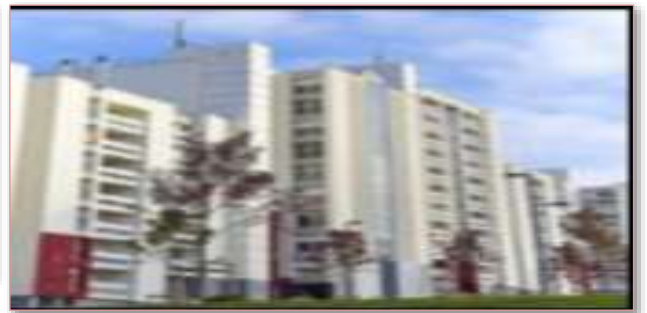
Fig 19: logements après la réhabilitation Source : https://www.youtube.com/watch?v=eytxBiHwgZA
