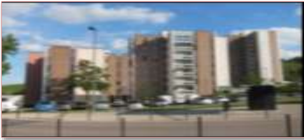
Fig 18: logements avant la réhabilitation. Source : https://www.youtube.com/watch?v=eytxBiHwgZ
