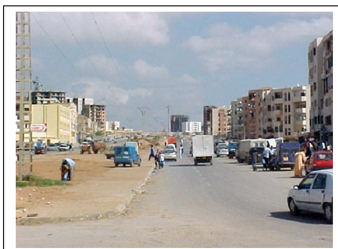
Figure II.9. Rupture dans le tissu urbain par ligne électrique et danger sur la population [12]
