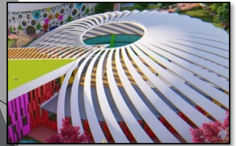
Figure 228:protection solaire Source: auteur
