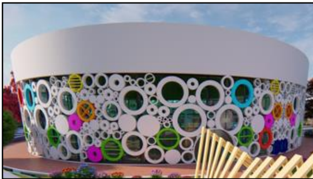
Figure 202:double peau de la salle du sport Source : auteur
