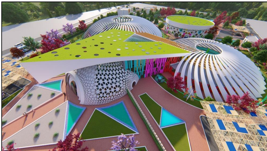
Figure 211:toiture végétalisée inclinée Source : auteur
