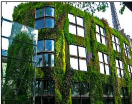
Figure 26 : façade végétalisée Source : www.construction21.org 15 :52 23/03/2019
