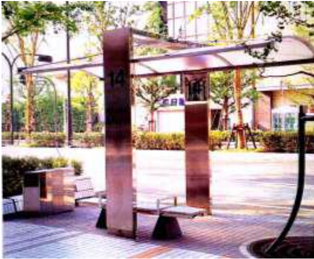
شكل 4-14- موقف باص من الصفائح المعدنية والبولي كربونات والألياف الزجاجية
