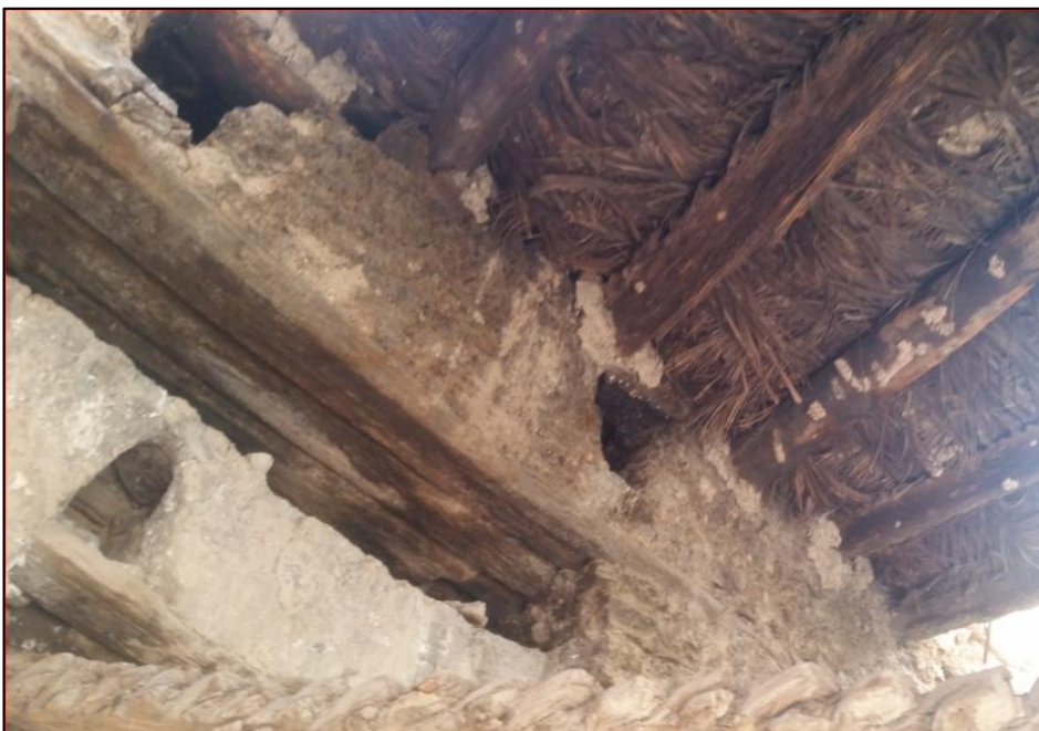
Figure 17: incendie des planchers source : auteure
