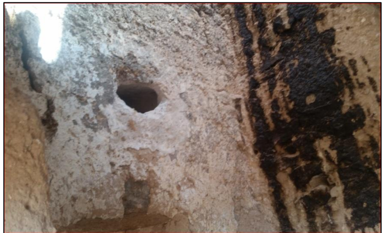
Figure 16: décollement de crépissage source : auteure
