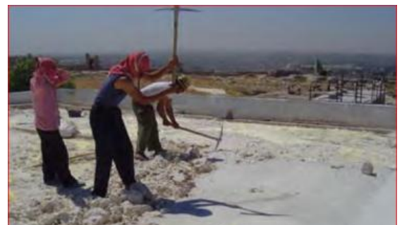
Figure 24: les travaux du toit
