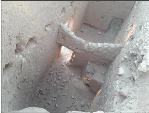
Figure 15: des trous au niveau des murs source : auteure
