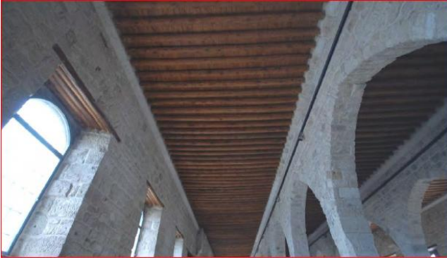
Figure 22: le toit de la caserne
