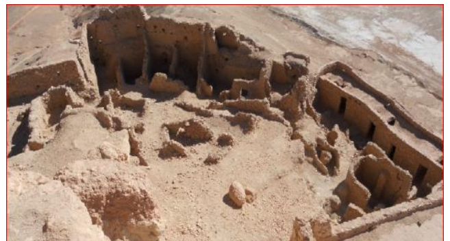
Figure 60:ksar El-Goléa au processus de dégradation source : auteures
