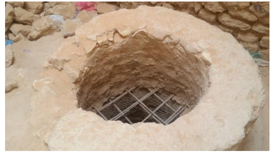
Figure 51: le puits source : auteures
