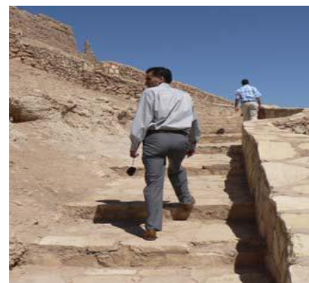
Figure 9: Escaliers et murets de protection en pierres construits en 2007
