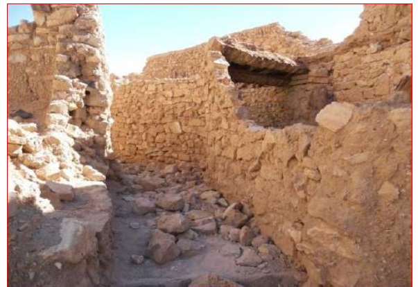
Figure 66: les combles des pierres source : auteures
