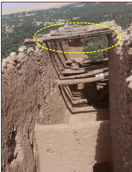
Figure 14: le fléchissement du tronc du palmier source : auteure
