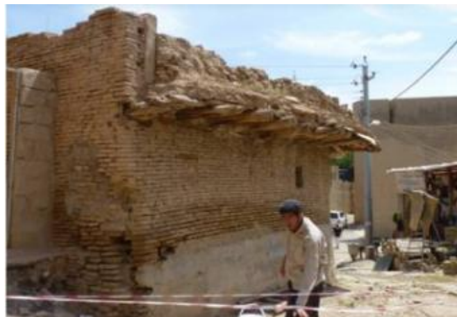
Figure 21: les travaux de restauration source : conservation of Erbil citadel ,Iraq
