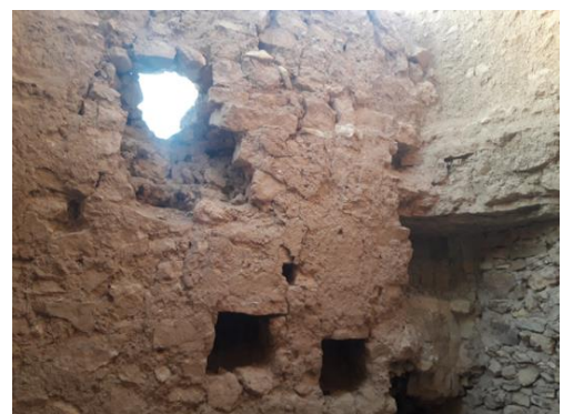
Figure 64: L'effritement du mortier source : auteures
