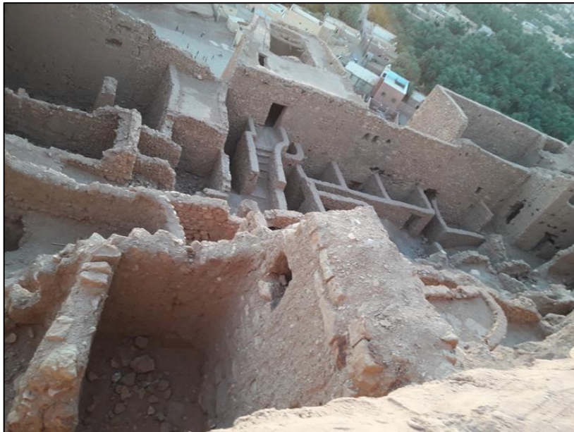
Figure 5: la kasbah à processus de dégradation source : auteure
