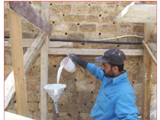
Figure 25: injection des murs extérieurs
