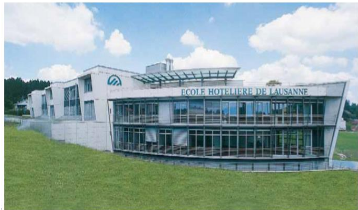
Figure 22 : Ecole d'hôtellerie de Lausanne , Suisse Source : CRP SUISSE
