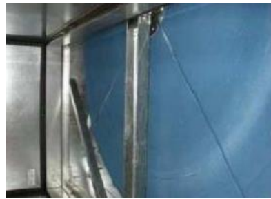
Figure 127 : Récupération thermique Source : www.researchgate.net
