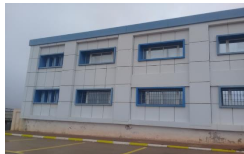
Figure 184 : centre de formation paramédicale façade principale RDC+1 (est) Source : auteur
