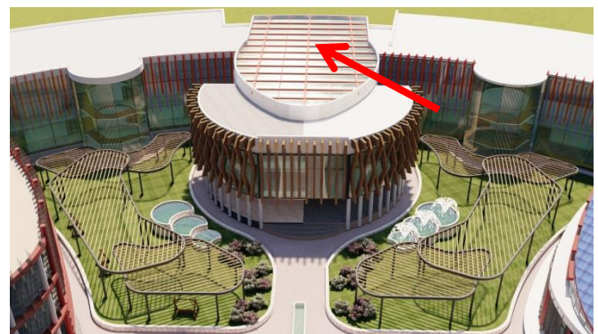
Figure 249: ventilation par atrium Source : auteur
