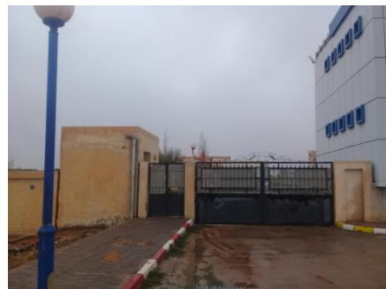
Figure 186 : centre de formation paramédicale entrée / façade secondaire (est) Source : auteur
