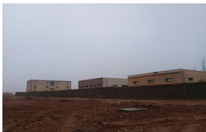
Figure 185 : centre de formation paramédicale façade secondaire RDC+2 (est) Source : auteur
