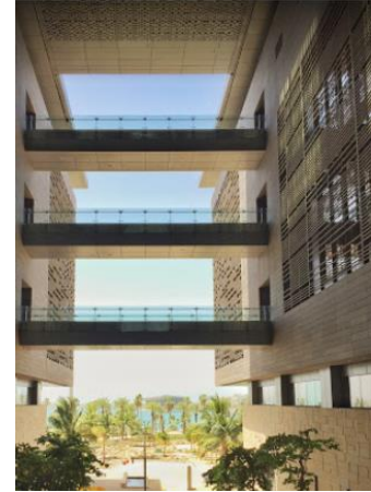
Figure 103 : passage entre les laboratoires Source : archdaily
