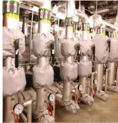
Figure 81 : Pompe à chaleur géothermique Source : www.thecrystal.org
