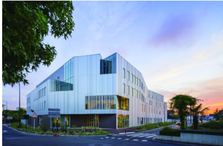
Figure 142 : Institut de l'hôtellerie et des arts culinaires (INHAC) Source : archdaily
