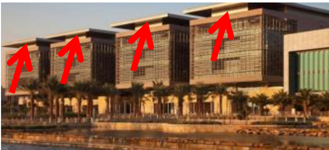
Figure 115 : ferme en béton (toits perforés)
