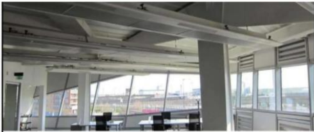
Figure 82 : Poutres froides Source : www.thecrystal.org
