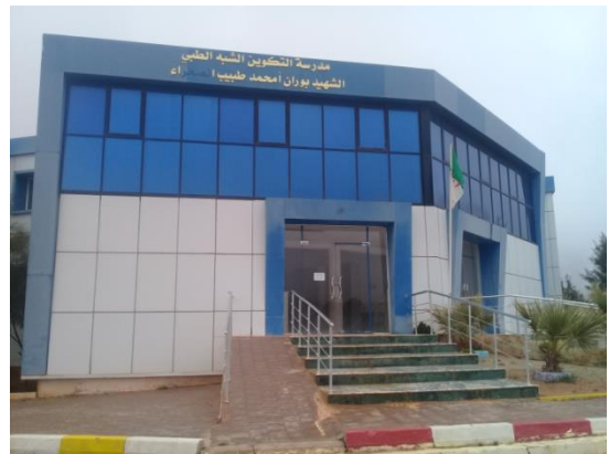
Figure 182 : centre de formation paramédicale entrée / façade principale RDC+1 (est) Source : auteur
