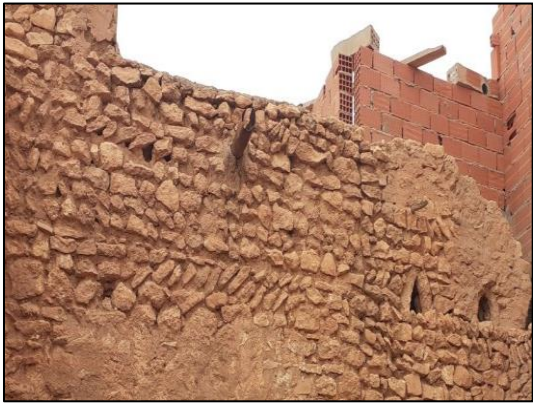
صورة 26 : الحجارة المستعملة في البناء وتقنيات التصفيف المصدر : من إعداد الطالب
