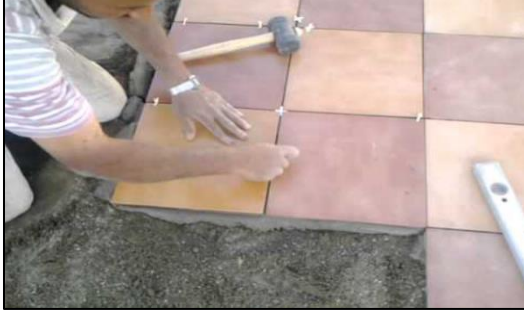
صورة 38 : توضح ترميم الارضيات المصدر : من إعداد الطالب
