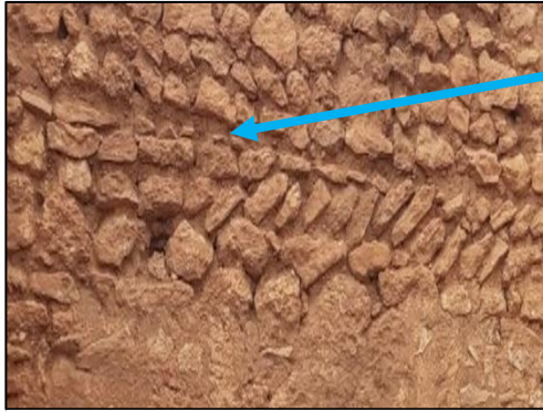
شكل 38 : إستعمال الملاط كمادة رابطة ( لاحمة )
