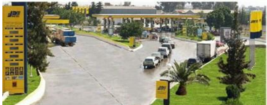
الصورة 11 : تمثل محطة خدمات نفطال
