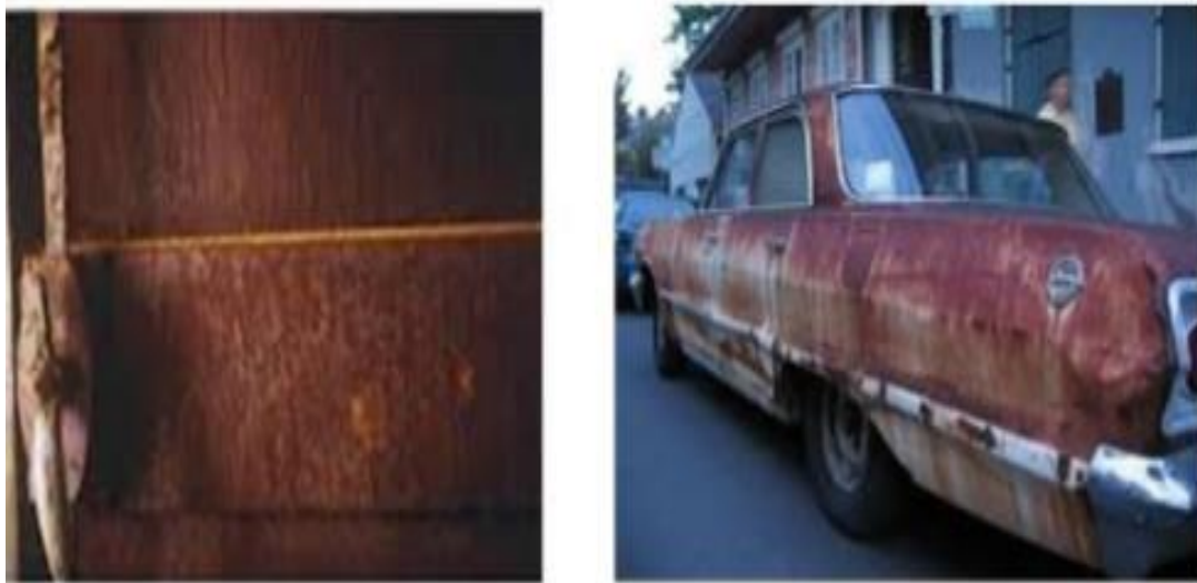
Fig III. 1: Corrosion générale (rouille) d'une pièce en acier. [10]
