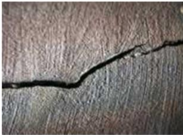
Fig III. 6: Exemple de la corrosion sous contrainte
