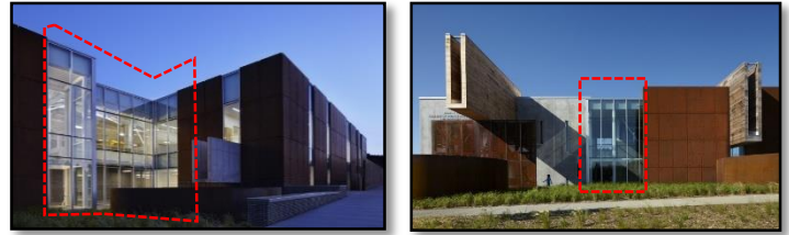
Figure 57: vue extérieure de bâtiment GCS. Source : www.aiatopten.org
