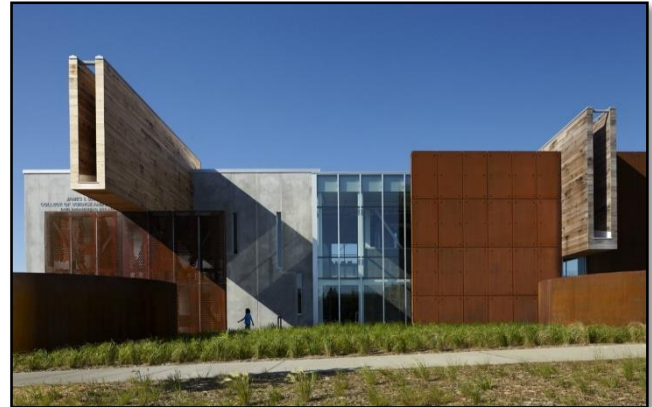
Figure 26 : Bâtiment de génie civil de Swenson (GCS) Source : web site d'archdaily
