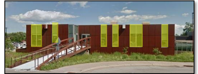
Figure 40: façade nord-ouest de bâtiment GCS. Source : www.studyusa.com
