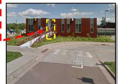
Figure 44: vue sur l'entrée d'ouest de bâtiment GCS Source: street view de Google
