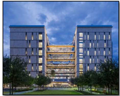
Figure 24: centre de recherche de Texas USA. Source : site web archidaily.
