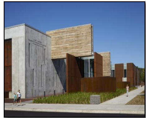
Figure 25: Bâtiment de génie civil de Swenson (GCS). Source : site web archidaily.
