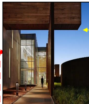
Figure 42: l'entrée principale de bâtiment GCS Source : www.aiatopten.org
