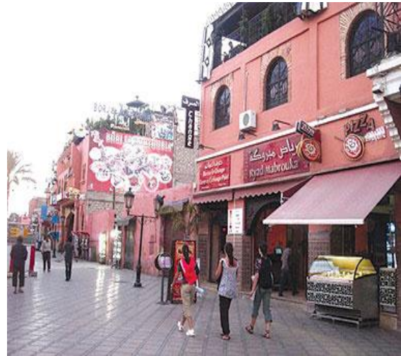
Fig II 19 : Les façades de la place après la réhabilitation [19]
