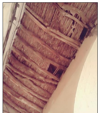
Figure 140-141-142 CH III : les pathologies de la galerie d'arcades de la place BEN SALEM (prise par les étudiantes)
