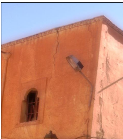
Figure 140-141-142 CH III : les pathologies de la galerie d'arcades de la place BEN SALEM (prise par les étudiantes)
