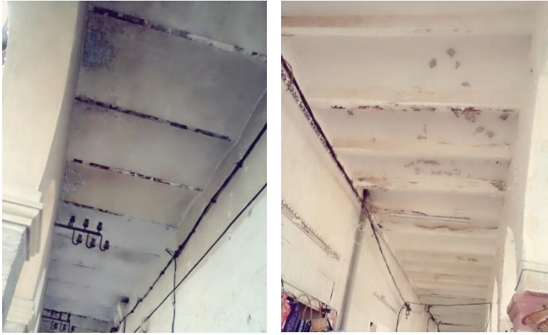
Figure 154-155 III : les voutains dégradés élaborer par les étudiantes
