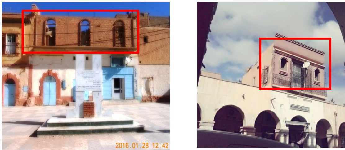
Figure172 -173 III : Démolition des rajouts élaborer par les étudiantes
