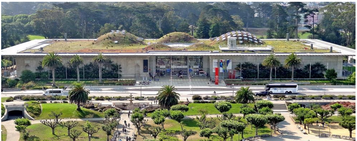
Fig I.58: Les façades , Source : http://www.actuarchi.com
