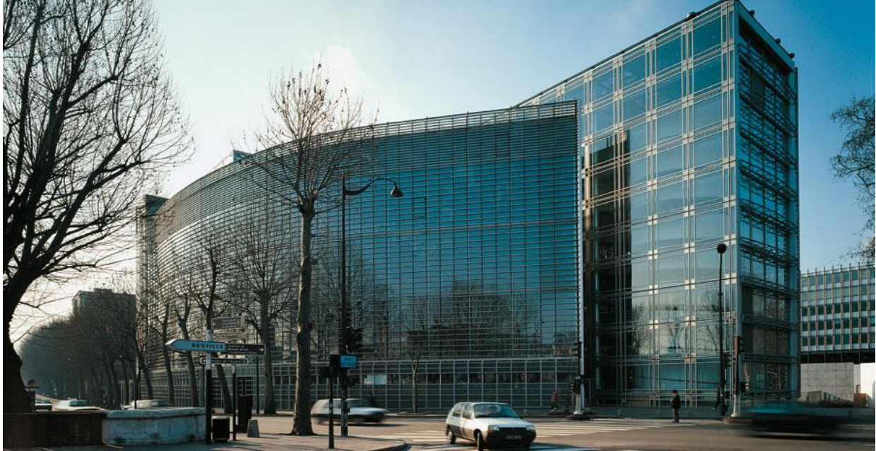
Fig I.42: la façade nord l'institut de monde arabe ,Source : livre de l'institut du monde arabe 94
