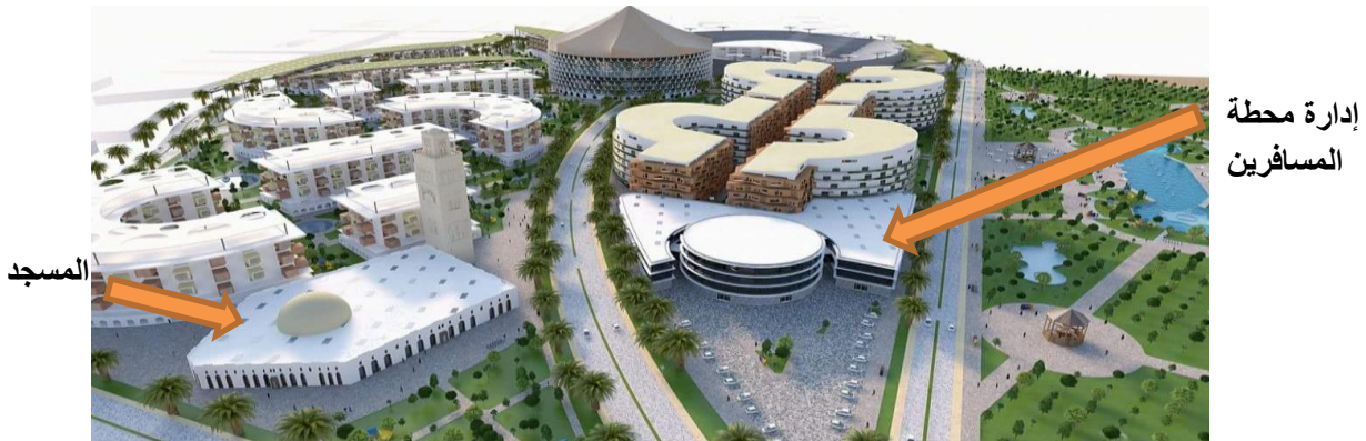
الصورة رقم (126) -توضح تركيب الألواح الشمسية فوق المسجد وإدارة المسافرين المصدر: من إعداد الطالب
