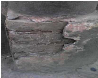
Fig. II.35: la brique cuite dans les murs/ les auteurs
