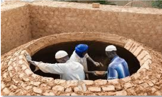
FigII.24 : les techniques de construction des coupoles [18]
