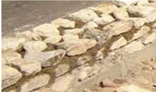
Fig. II.3: utilisation des pierres avec le mortier -colle [12]
