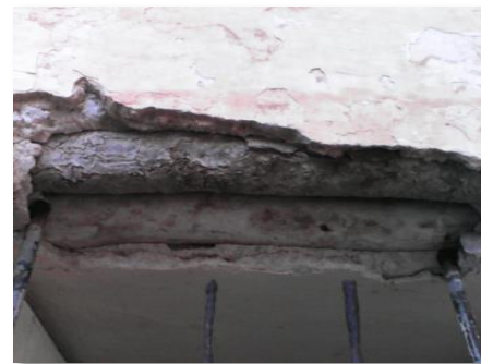
Fig. II.36. : Le bois de peuplier en linteau/ les auteurs
