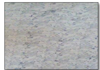
Fig.32 : le crépissage traitement de mur / les auteurs
