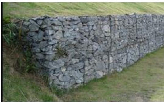
Fig. II.1 : le gabion [12]
