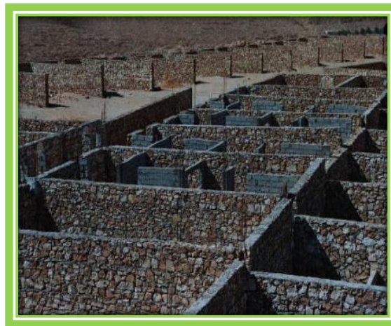
Figure 40: Construction des murs en pierre
