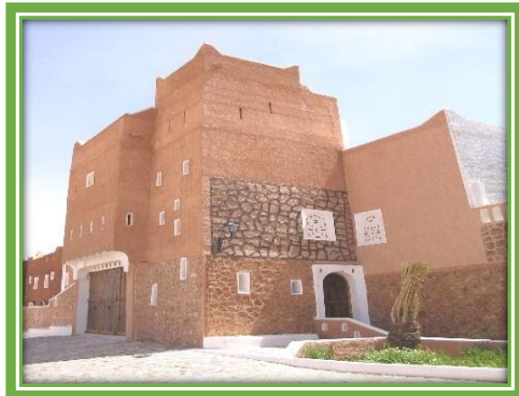
Figure 33: photo présent traitement de façade
