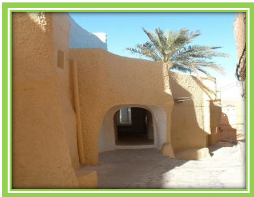
Figure 72: l'entrée de la maison (La Porte)
