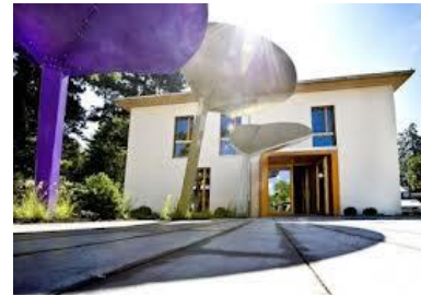
Figure I.16: façades principale de l'exemple 2, MAGAZINE DE CHANTIER
