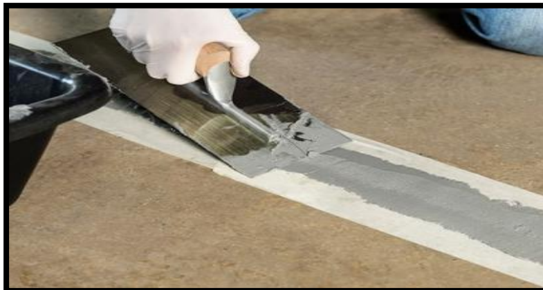
Figure I.21. Exemple de travaux de réparation et jointoiment.
