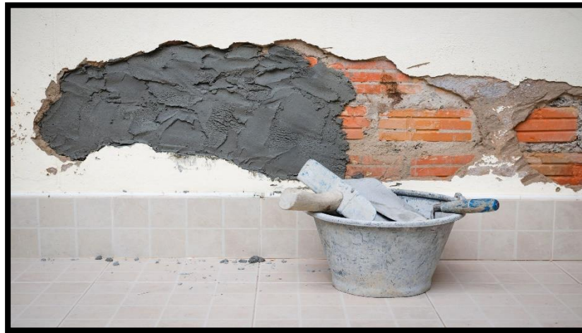
Figure I.19. Exemple d'utilisation de mortier modifié aux polymères dans murs.
