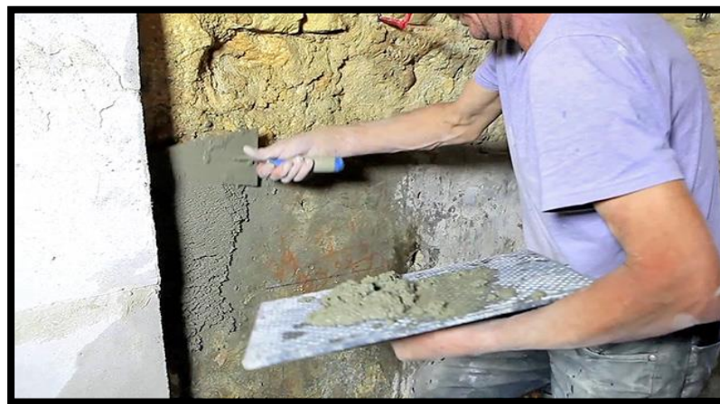
Figure I.20. Exemple de travaux de réparation et de restauration historique.
