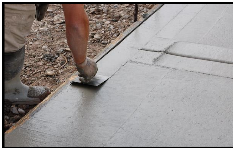
Figure I.18. Exemple d'utilisation de mortier modifié aux polymères dans construction et réparation de béton.
