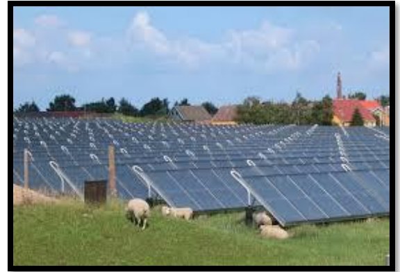
Figure 11: les panneaux d'Energie solaire. Source : www.planete-energies.com
