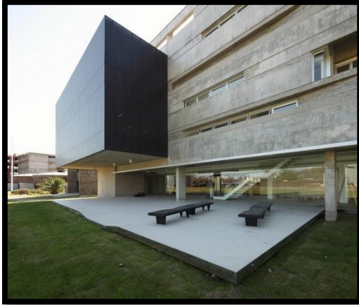
Figure 7 : Volume du bâtiment de l'Institut de recherche biotechnologie. Buenos Aires- Argentine. Source : www.archdaily.com
