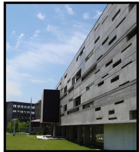
Figure 9 : le matériau utilisé au niveau de façade. Source : www.archdaily.com
