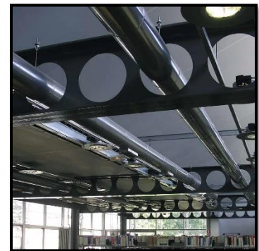
Figure 6: poutre alvéolaire. Source : www.archiexpo.fr
