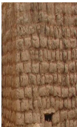
Figure 68 : façade en adobe
