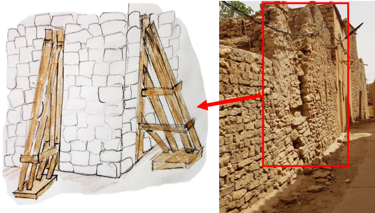
Figure 117:etaiement d'un mur
