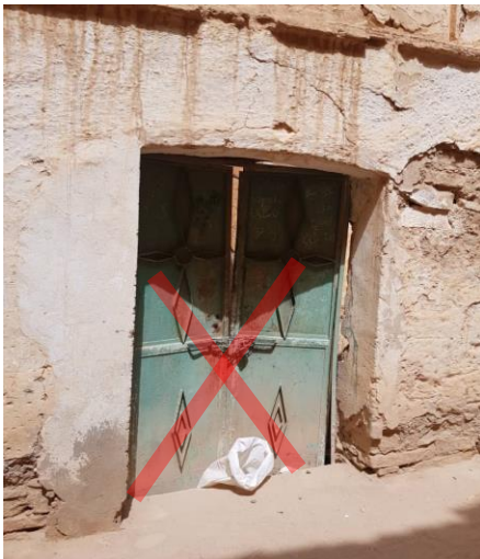
Figure 163: porte d'une maison ksourienne Source: auteur
