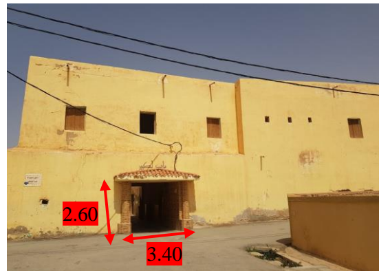
Figure 77: Bab El Kabir Source : auteur
