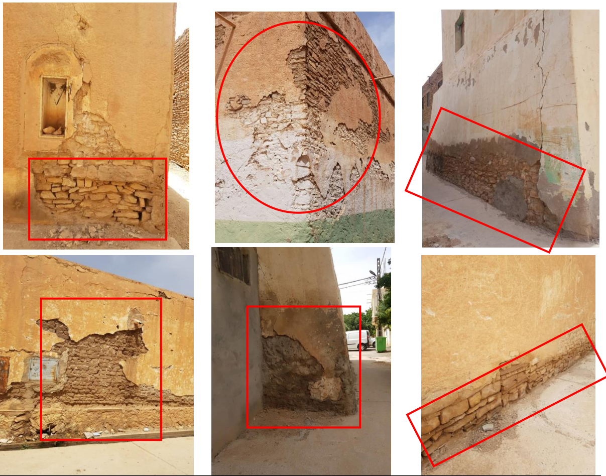
Figure 123 : décollement d'enduit
