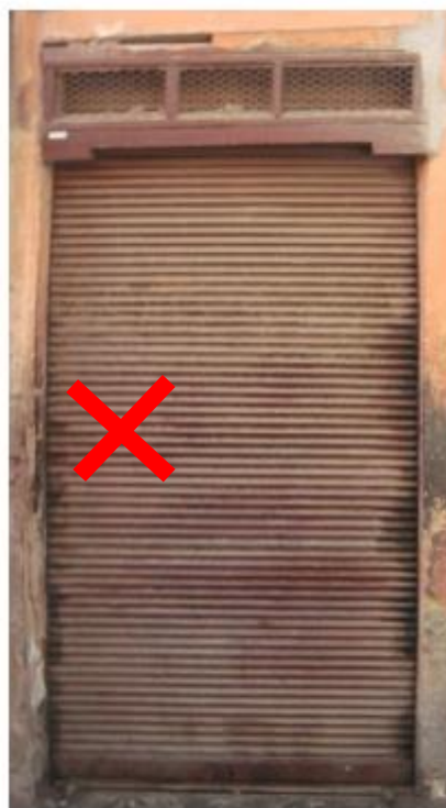
Porte métallique sous forme de volet roulant
