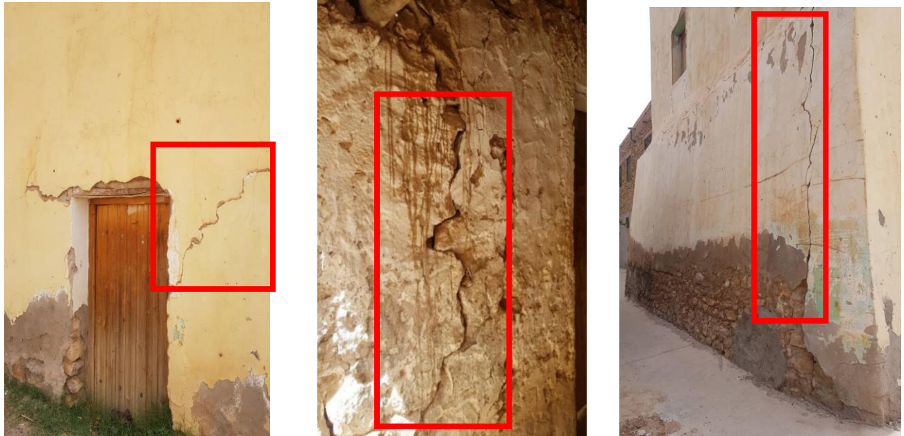
Figure 121 : fissures superficielles
