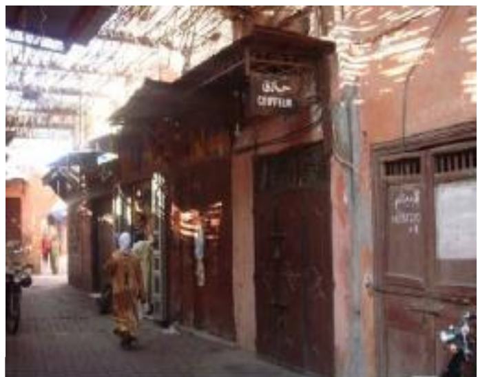
Figure 17 : façades de la rue commerçante Derb el Maaden à médina de Marrakech Source : www.montada-forum.net
