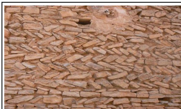
Figure 98: technique de l'opus spicatum Source : auteur
