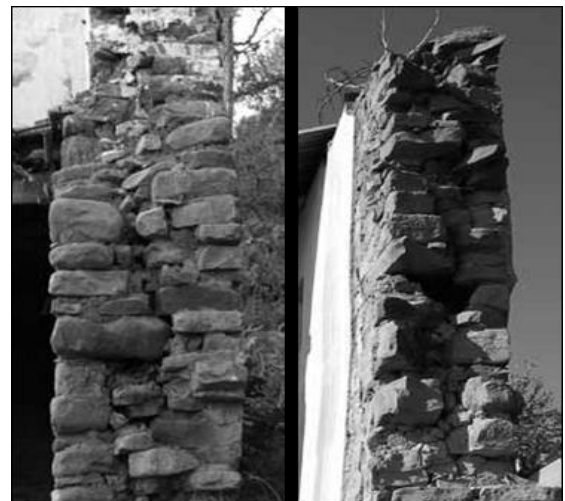
Figure 42: le mur bombé Source : PDF manuel pour la réhabilitation de Dellys. Montada
