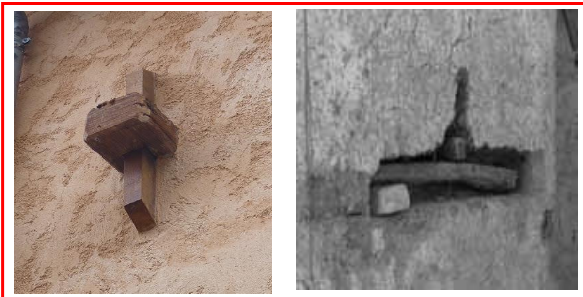
Figure 47: pièce d'ancrage en bois
