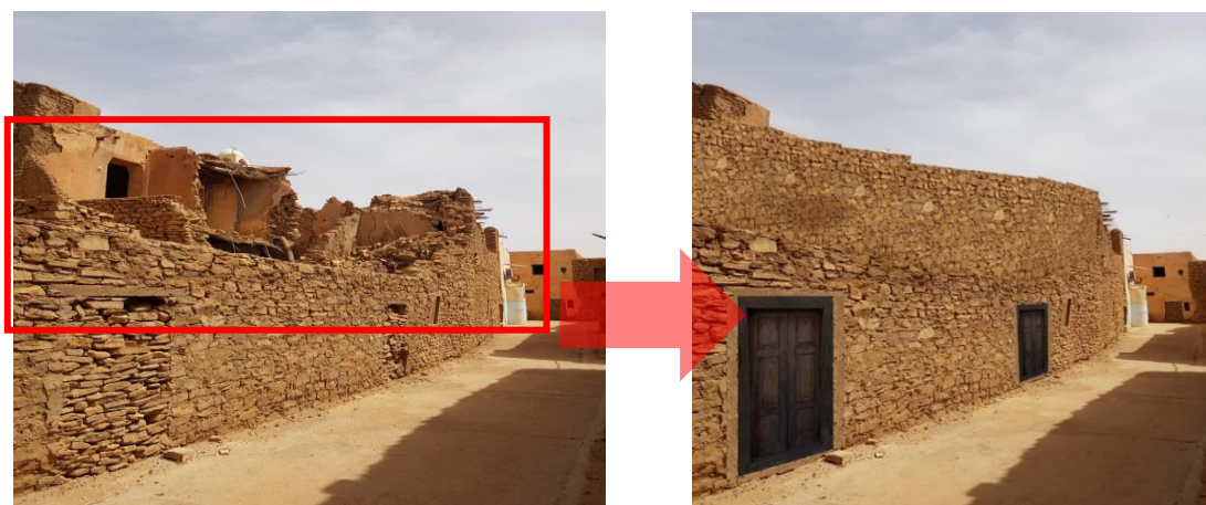
Figure 143:avant et après la reconstruction de mur
