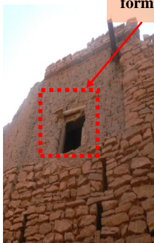
Figure 67 : façade en pierre et adobe
