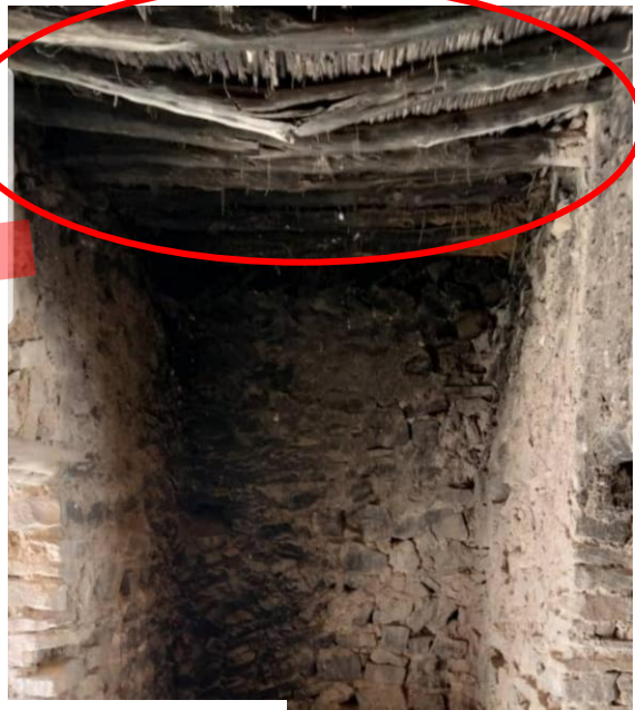
Figure 116:etalement du plancher
