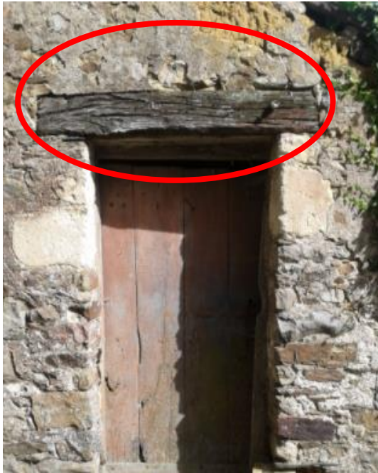
Figure 30 : linteaux en bois Source : Pinterest
