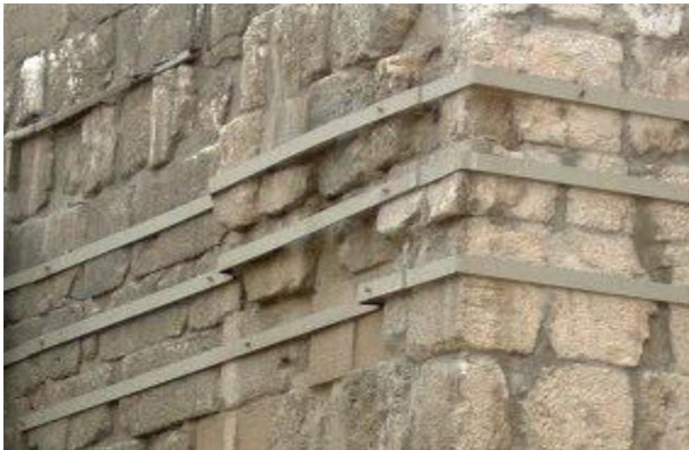
Figure 146 : renforcement des murs de minaret de mosquée des Omeyyades à Damas
