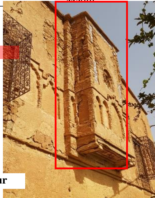
Figure 115 : Consolider l'encorbellement et le mur
