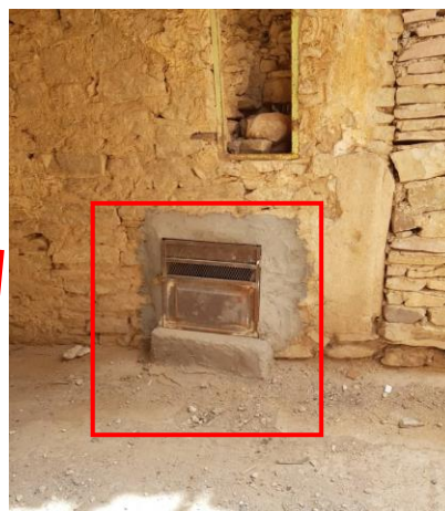
Figure 133 : Introduction des matériaux hétérogènes
