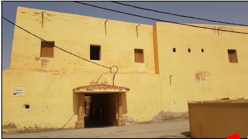
Figure 170 : façade de Bâb el Kabir
