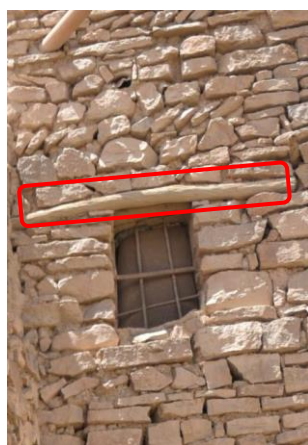
Figure 102 : linteau en bois d'une fenêtre Source : auteur
