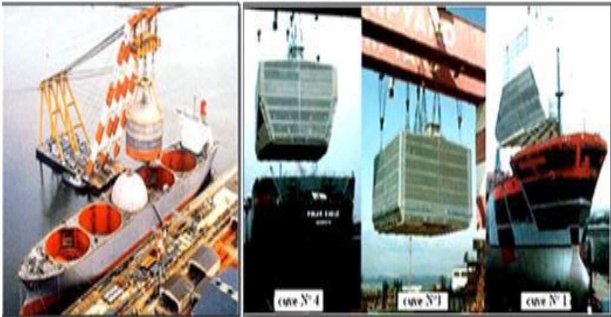
Figure VI.10. Montage des cuves auto porteuses
