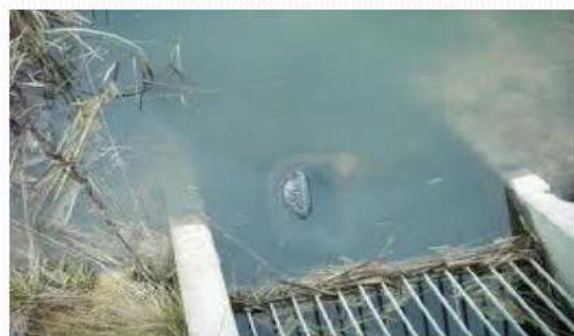
Figure I.2.5 : Exemples de flottants retenus par un dégrilleur.
