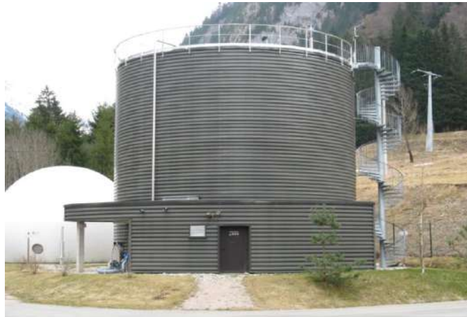
Figure II.5.3 : digestion des boues
