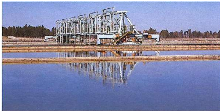
Figure I.3.19 : Décantateur à pont transbordeur (4 fois 50 m X 200 m).
