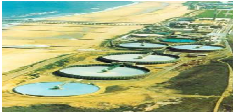
Figure I.3.17 : Décanteurs 78 et 98 m de diamètre
