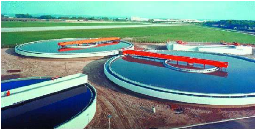
Figure I.3.16 : Installation de CANNES (Alpes-Maritimes). Débit maximum : 5500 \text{ m}^3 / \text{h} . Décanteur-floculateur.
