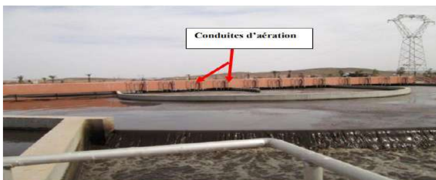
Figure II.3.23 : Le bassin d'aération (ou bassin biologique)
