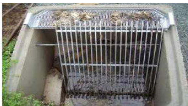
Figure I.2.6 : Les grilles manuelles
