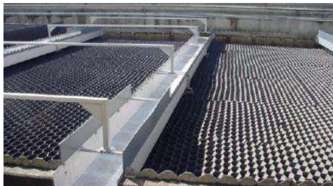
Figure I.3.29 : Décanteur à tubes inclinés
