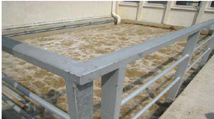
Figure I.3.58 : Lavage d'un bassin de filtration rapide
