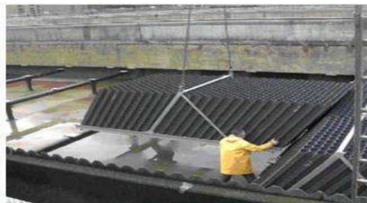
Figure I.3.26 : Décanteur à tubes fortement inclinés
