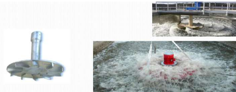
Figure II.3.17 : Les aérateurs de surface
