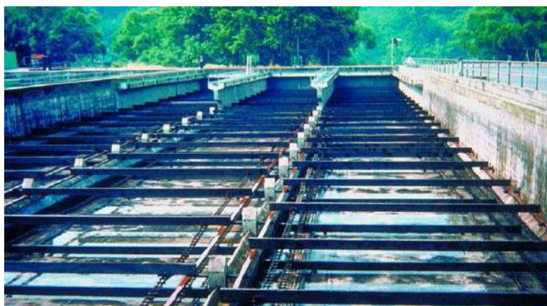
Figure I.3.21 : Installation de AIRE pour le traitement des effluents de GENÈVE (Suisse). Débit: 3,6 \text{ m}^3/\text{s} . Un des 8 décanteur à chaînes de 70 m X 18, 5 m.
