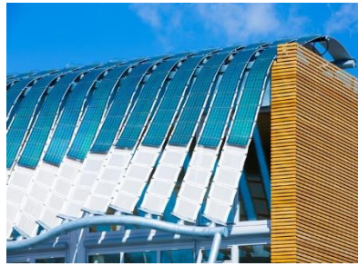
Figure 271 : Panneaux photovoltaïques Flexible . Source : traité par l'auteur.
