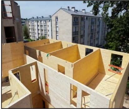
Figure 246 : cloison en bois lamellé croisé. Source : www.habitatnaturel.fr
