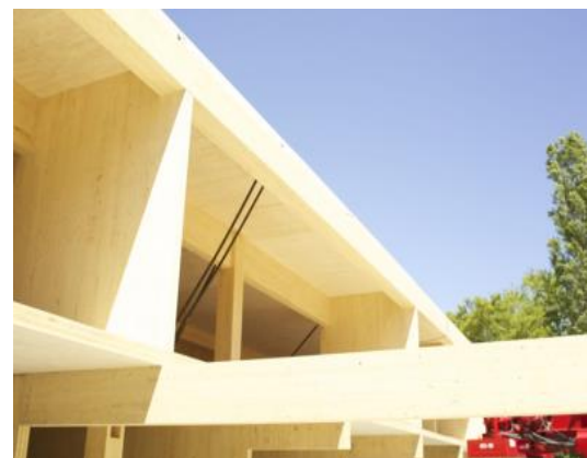
Figure 235 : Montage des panneaux CLT. Source : www.cdsl.qc.ca.com
