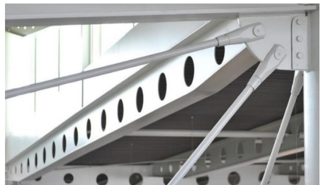
Figure 233 : poutre métallique alvéolaire Source : cours structure M1. UATL.
