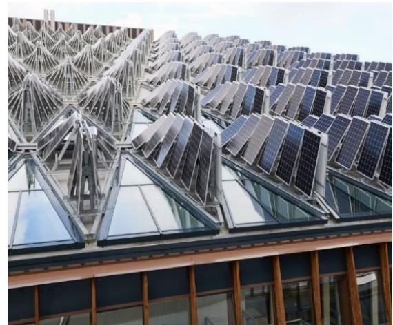
Figure 98 : Les panneaux Solaire. Source : archidaily.com.
