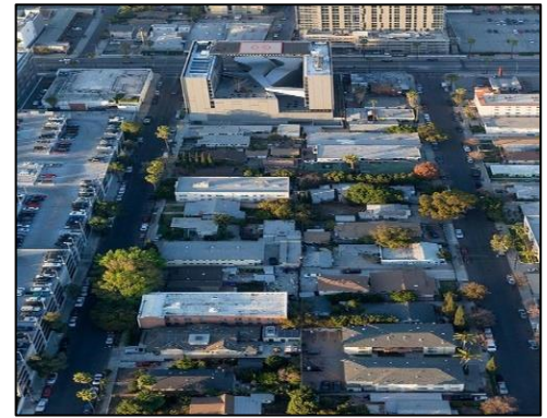
Figure 76 : voisinage du projet.
