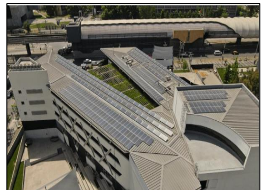
Figure 72 : vue des panneaux photovoltaïques au toit Source : www.archidaily.com
