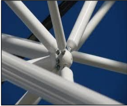
Figure 237 : Structure tridimensionnelle système méro. Source : www.inexhibit.com
