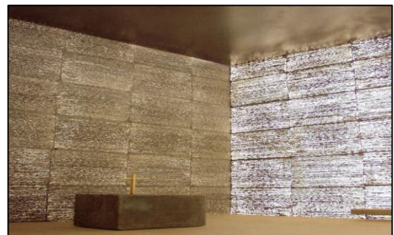
Figure 247 : cloison en bois lamellé croisé. Source : www.habitatnaturel.fr
