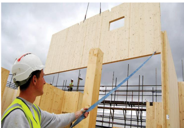
Figure 235 : Montage des panneaux CLT. Source : www.cdsl.qc.ca.com
