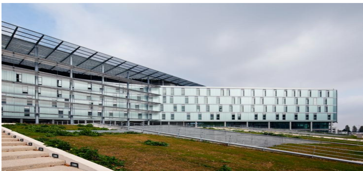
Figure 34 : Façade sud, longue courbe sur 200m
