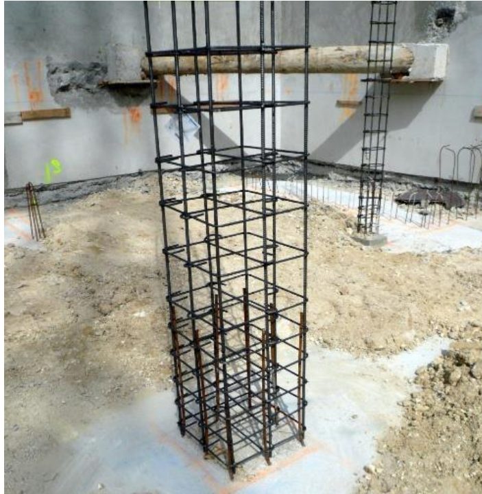
Figure 4.10. Ferrailage général de Poteau
