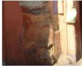
Remontée capillaire propagation de l'humidité
