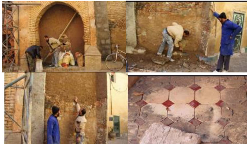
Figure 41: les travaux de la réhabilitation [36].
