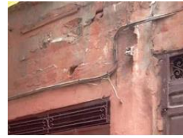
Câbles électricité apparent
