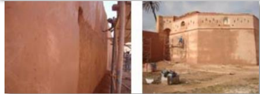
Une texture et une coloration compatibles avec celles du mortier à remplacer ou d'un mortier précédent, pour préserver l'authenticité historique et l'esthétique
