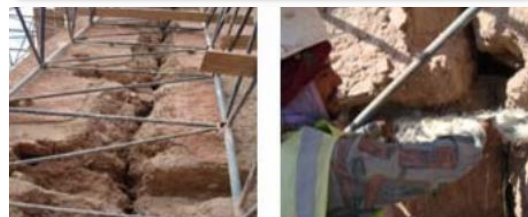
Reconstruction des parties dégarnies de la fissure en briques cuites
