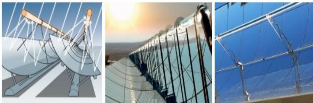
Figure 1.11. Réflexion des rayons solaires sur le tube absorbeur
