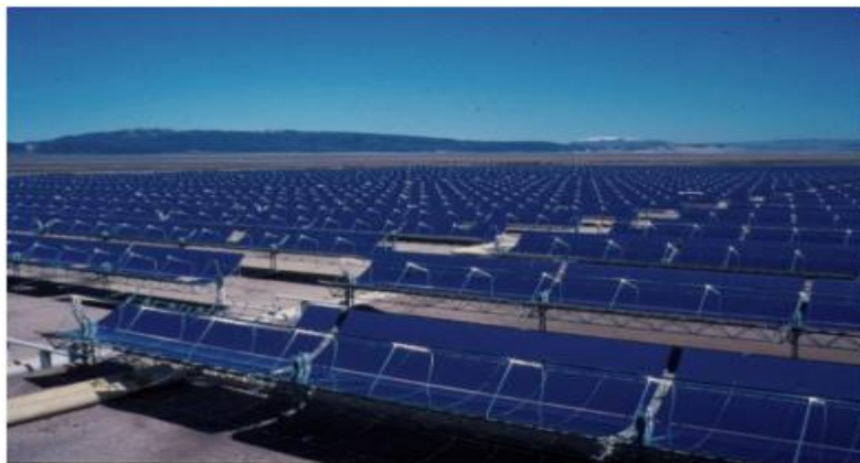
Figure 1.4. Vue montrant une partie de la centrale SEGS en Californie [11]
