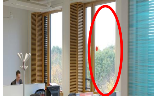
Photo10:vue à l'intérieure Source : http://www.green-office.fr
