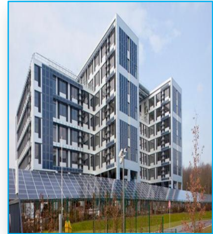
Photo 4: vue générale du GREEN OFFICE Source : http://www.green-office.fr
