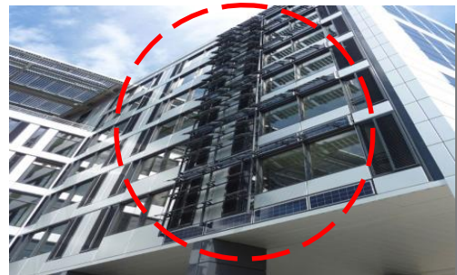
Photo08: positionnement des panneaux photovoltaïques, et des brises soleil.
