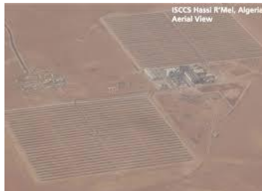
Figure 5.2 : Vue Aérienne de la centrale hybride (solaire – gaz) de Hassi-R'mel.
