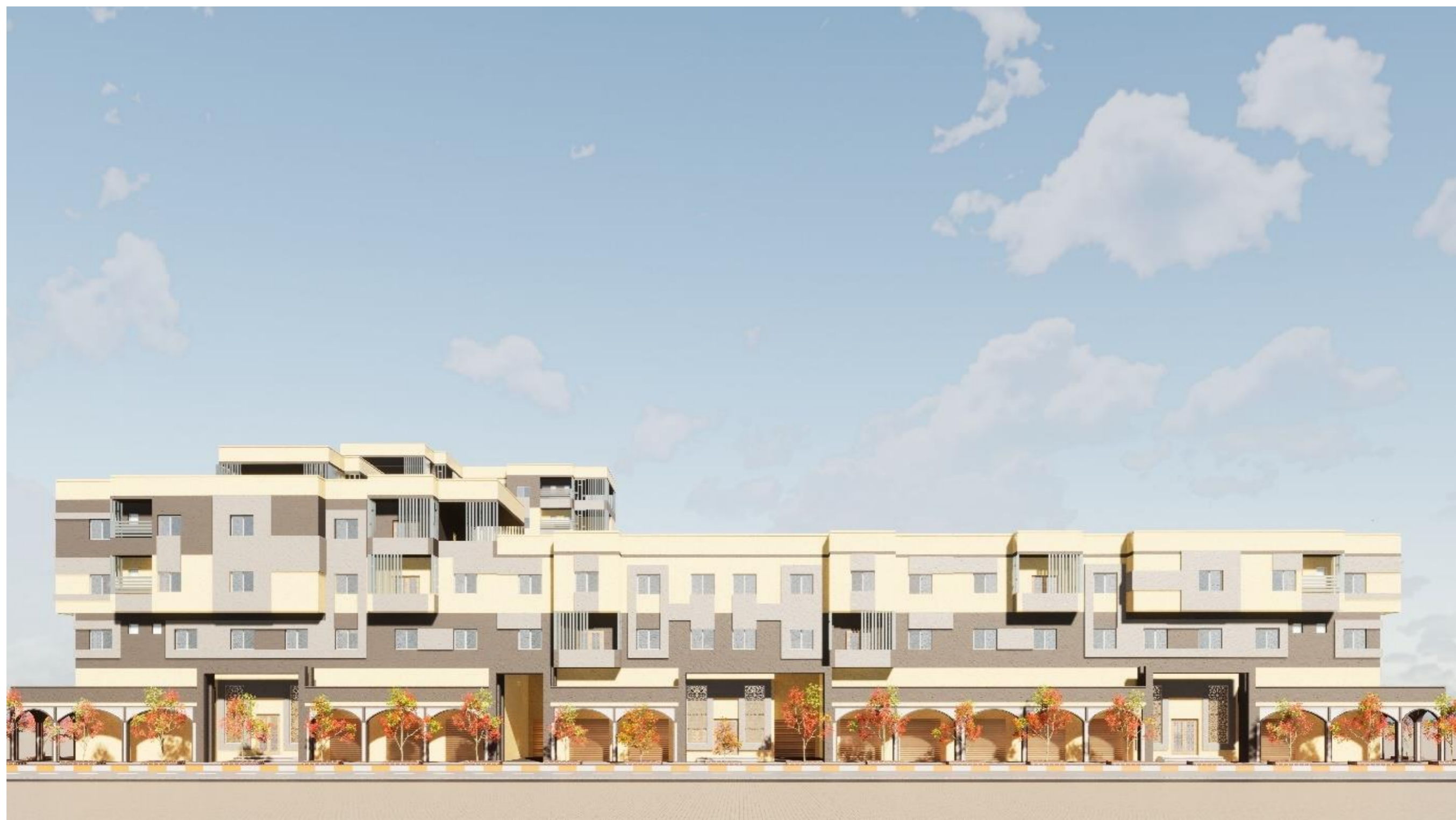
صورة 123 توضح واجهة المشروع للجهة اليمنى
