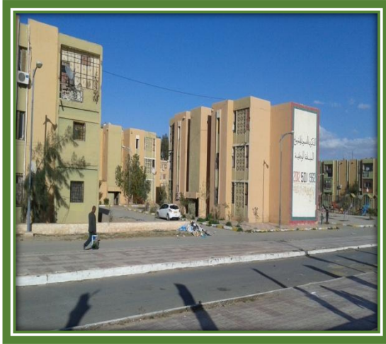
Photos N°40 de la zone Source: prise par l'auteur
