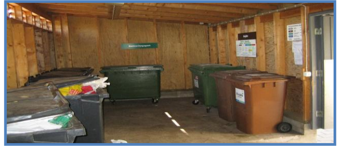
Image N°05:Construction pour le tri des déchets. https://encrypted-tbn1.gstatic.com .
