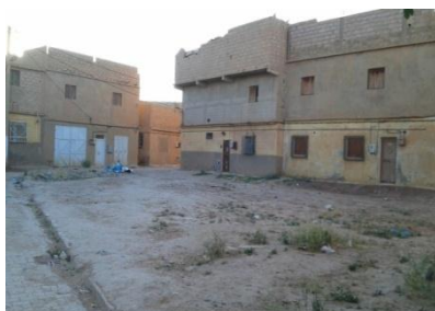
Figure 140: bâti en bon état
