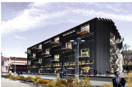
Figure 16: L'ancien bâtiment des douanes est réhabilité, source : www.lyon-confluence.fr
