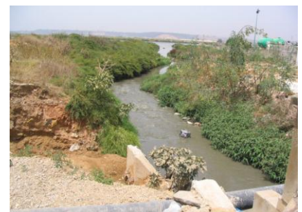
Figure 55: des dizaines de rejets d'eaux usées
