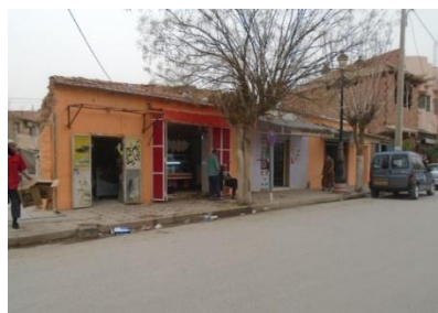
Figure 141: bâti en moyen état
