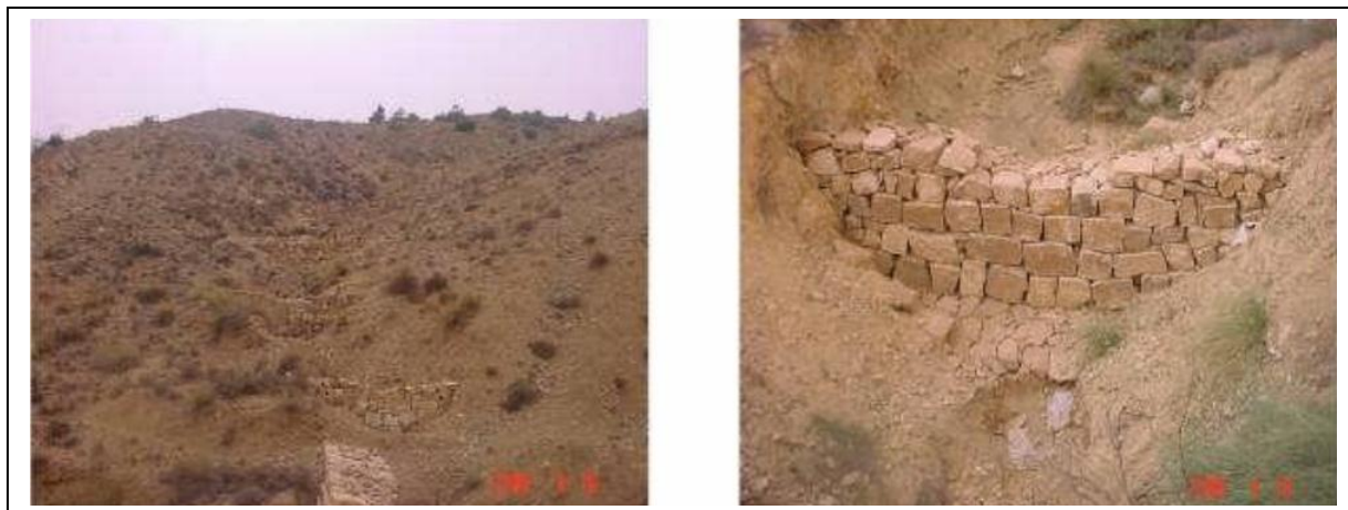
Figure 39: Fig. : la correction torrentielle, source : auteurs
