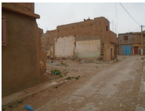
Figure 149:espaces libre en accolement a la rue, source : étudiants
