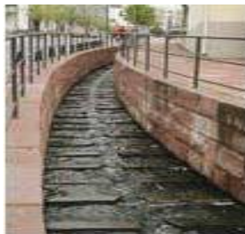
Figure 35: Système de drainage des eaux pluviales, source : www.hammarbysjostad.se
