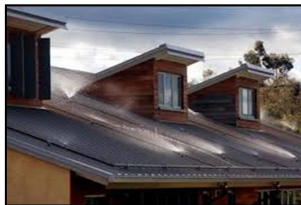
Fig.II-47 Système de refroidissement par pulvérisation de l'eau sur le toit [Source : http://dgc.stanford.edu/about/building ]
