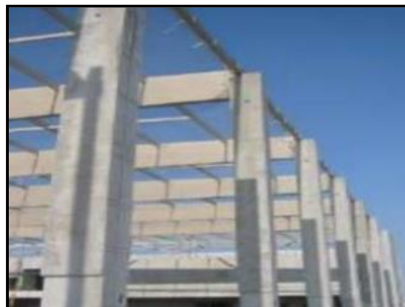
FigVI.35: ossature en béton armé [Source : http://www.calcia-infos.com ]
