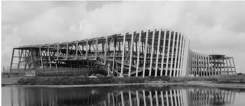
Figure 28: la charpente métallique. Source : Archdaily.com
