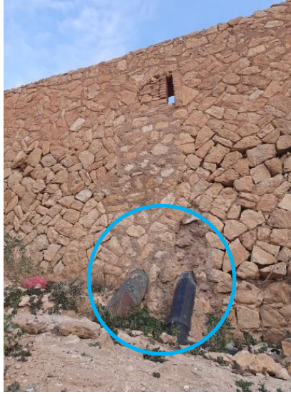
الشكل III_13: انابيب الصرف الصحي المصدر : من تصوير الطالبة
