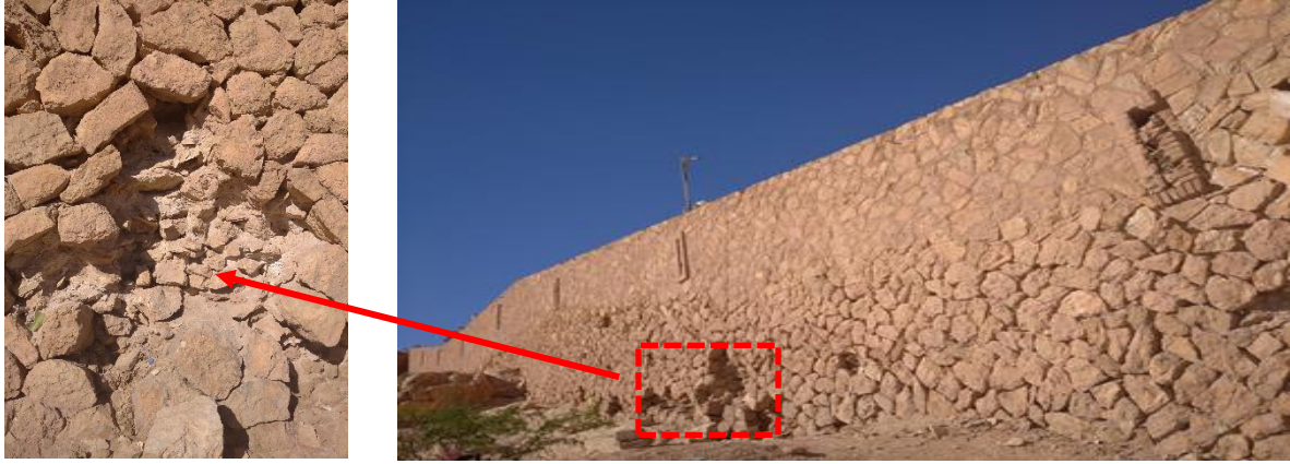
الشكل III_15 : حت و سقوط مونة الجير و اجزاء من الحجارة المصدر : تصوير الطالبة
