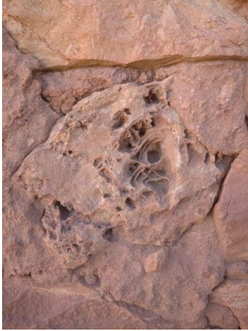
الشكل III_19: التلف على شكل خلايا النحل بسبب الرياح القوية المصدر : تصوير الطالبة
