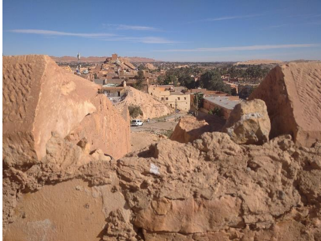
الشكل III_14: اجزاء مفقودة من حائطة السور المصدر : من تصوير الطالبة
