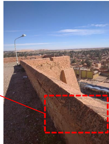
الشكل III_18: صورة توضح مظهر الاشنة علو مستوى اجزاء من السور المصدر : تصوير الطالبة
