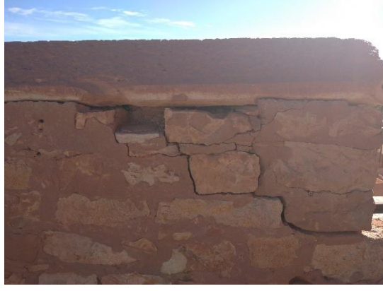
الشكل III_19: شقوق على مستوى السور ( الجزء ب) المصدر : تصوير الطالبة
