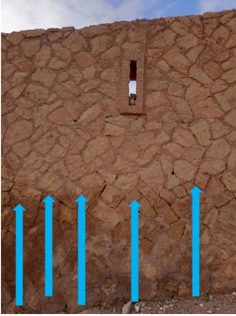
الشكل III_17: ارتفاع مستوى الماء في السور
