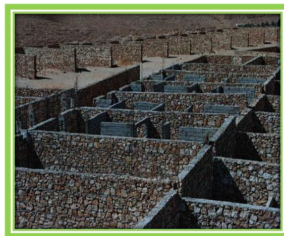
Figure 40: Construction des murs en pierre
