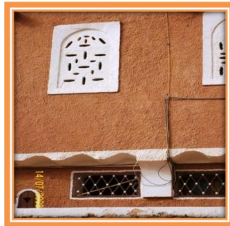
Figure 37: Protection des ouvertures et texture rugueuse
