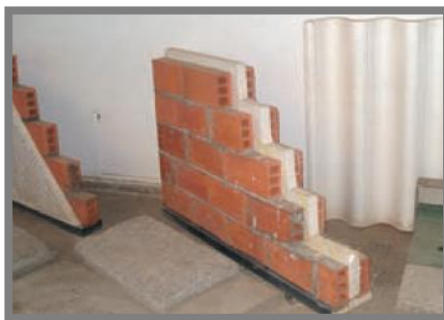
isolation par l'extérieure Parois vertical par polystyrène Source: réseau des Enterprise maghrébines pour l'environnement
