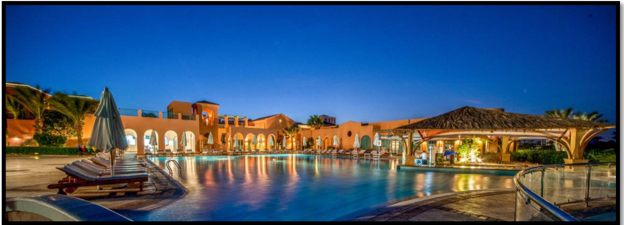
Figure 24: vue sur hôtel .source : www.sheratounmiramar.com .
