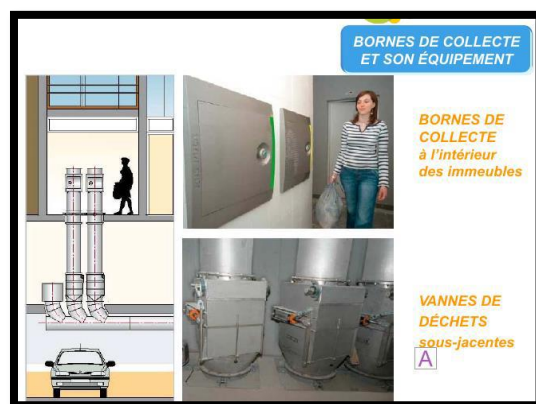
Figure N209: bornes de collecte et réseau de transport source : www.vitry94.fr .
