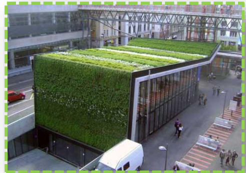
Fig 12 : le toit et le mur végétaux
