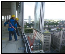
Fig 131 : la mise en œuvre de mur rideau
