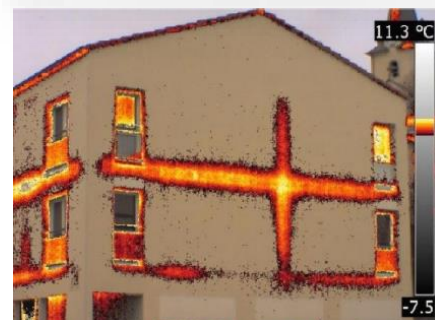
Fig 09 : les positions des ponts thermiques Source : http://www.e-rt2012.fr
