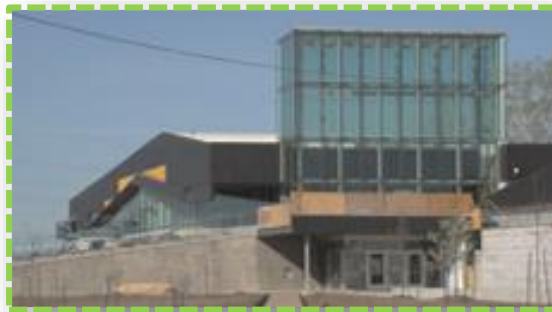
Fig 50 : des vues sur lanterneau Source : http://artpublic.ville.montreal.qc.ca
