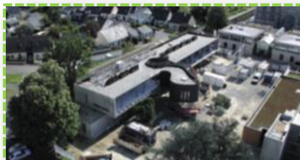
Fig 26 : vue aérien sur la bibliothèque Source: http://www.derbigum.fr
