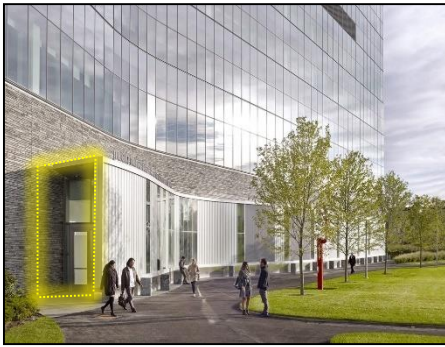
Figure 53 : Entrée secondaire d'office
