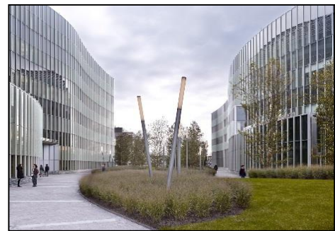
Figure 76 : jardin au milieu du centre de recherche science avancé Cuny
