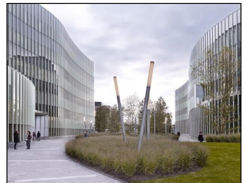
Figure 56 : Entrée principale bâtiment 02
