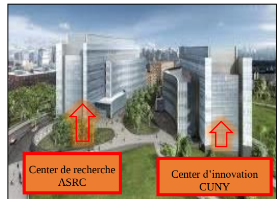
Figure 60 : les deux bâtiments de C.R Source : Archdaily.com.
