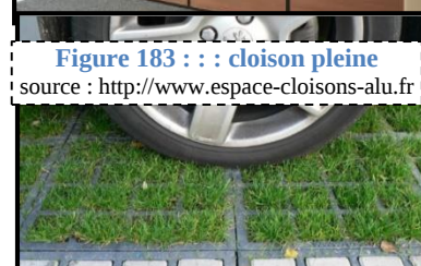
Figure 184 : : dalle alvéolée source : Guide bâtiment durable. Brussels
