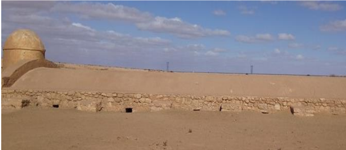
Figure 89 Façade latérale droite source auteur
