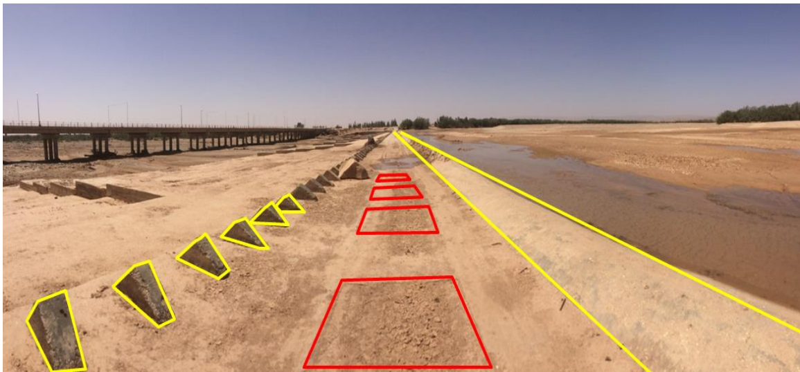
Figure 75 le barrage de Tadjmout source:auteur
