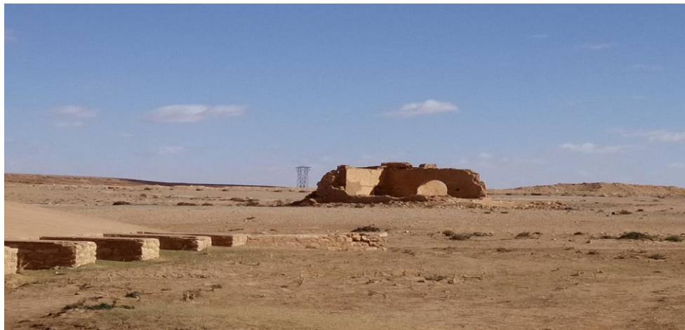
Figure 82 Vue sur le Four à chaux source:auteur
