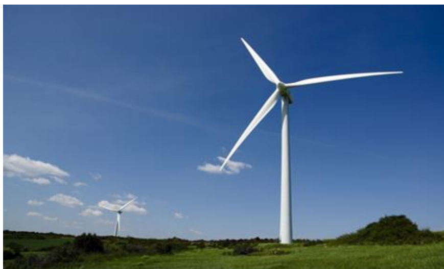
Fig.I.3 : Aérogénérateur à axe horizontal
