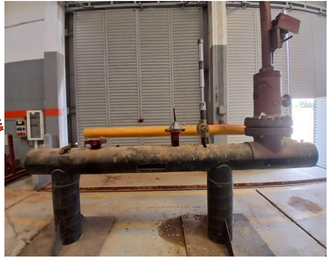
Figure 3 .6 : Obturation a deux positions avec by-pass provisoire
