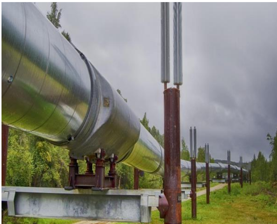
Figure 1.4 : Les Gazoducs De Transport
