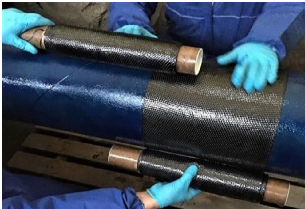
Figure 3.8 : Application d'un système de réparation composite sur pipe
