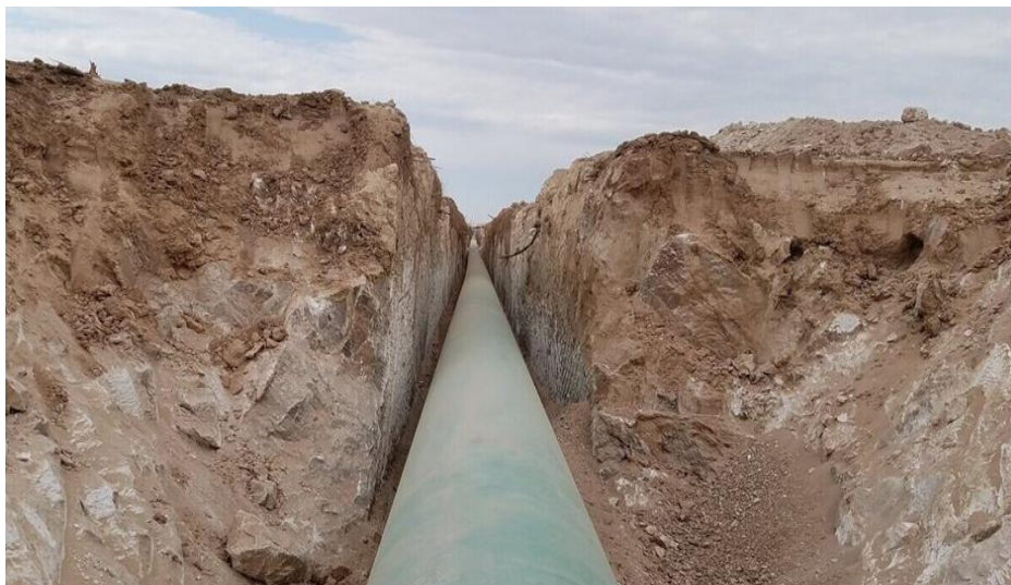
Figure 1.1 : Installation d'un gazoduc dans une tranchée
