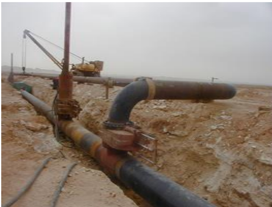
Figure 3.7 : Le piquage en charge
