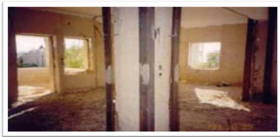
Figure II.9: Renforcement de poteaux Au moyen de profils Métallique (Hicham, 2009)
