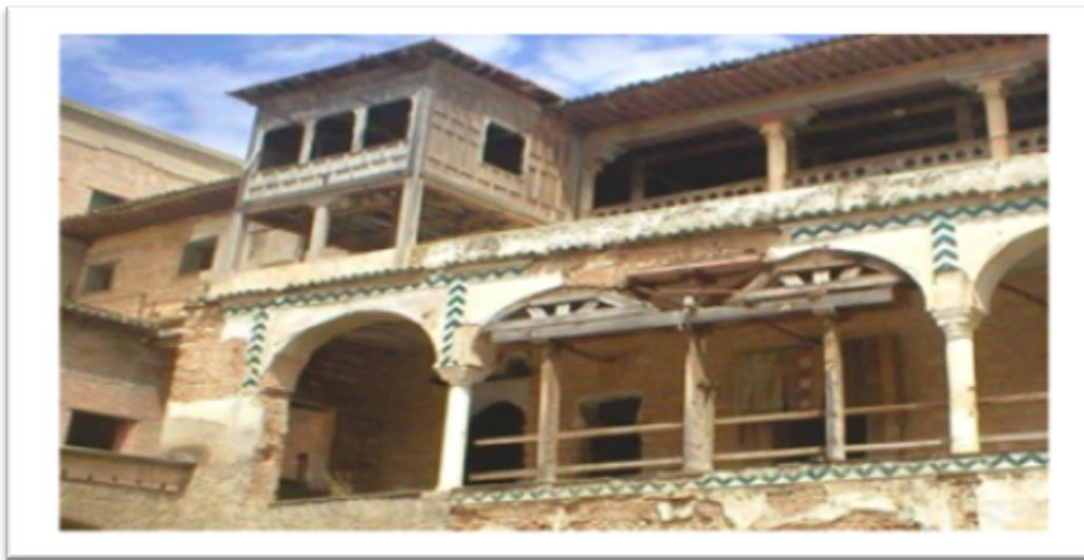
Figure II.2: Restauration de la citadelle d'Alger (palais du dey) a la casbah d'Alger
