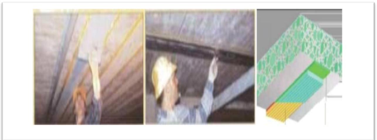
Figure II.8: Procède par collage De plaque (sika, 1996)
