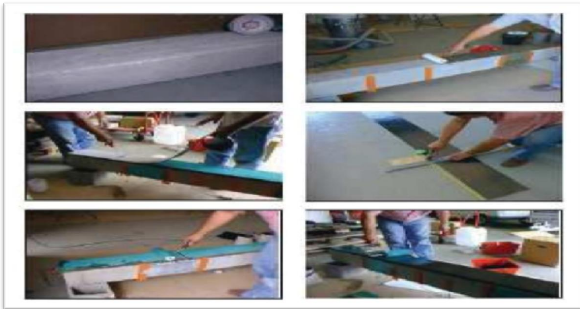
Figure II.7: Mise en œuvre par Stratification directe
