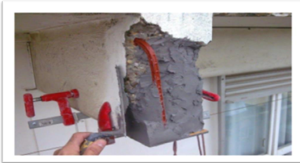
Figure II.3: Réparation de béton
