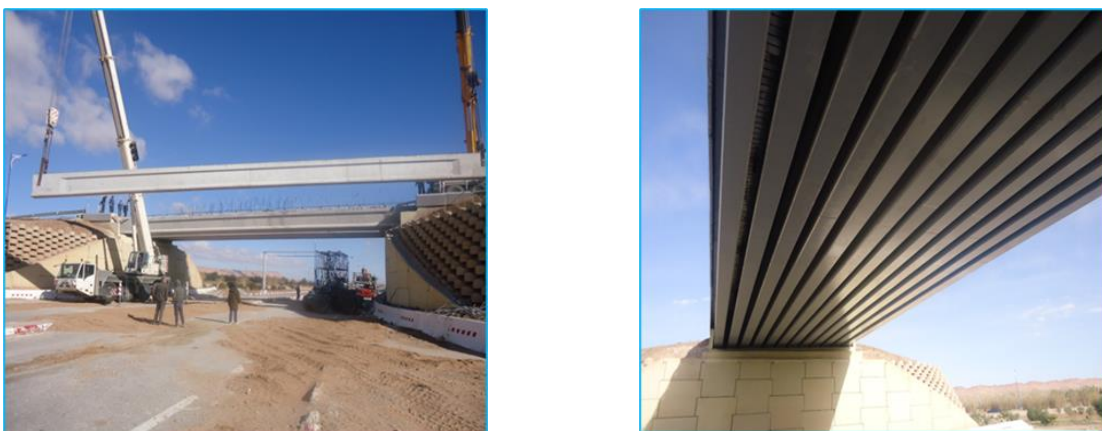
Figure III. 9: Pose des nouvelles poutres
