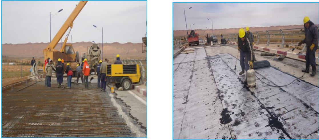
Figure III. 10: Reconstitution de la partie de la dalle démolie
