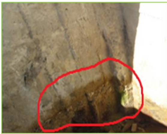
Figure III.24 : Dégradation des parois intérieures de galerie sous l'effet de perméabilité
