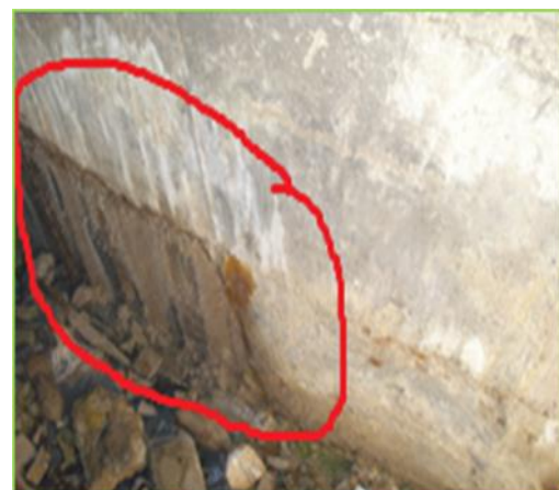
Figure III.24 : Dégradation des parois intérieures de galerie sous l'effet de perméabilité
