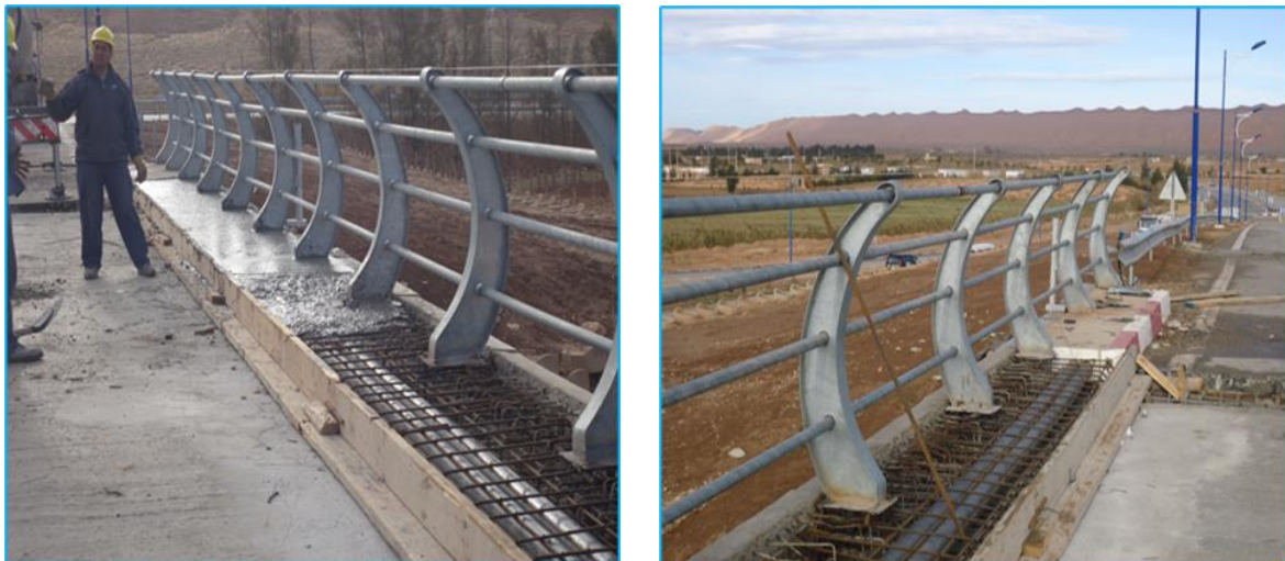
Figure III. 11: Reconstitution du trottoir et pose garde-corps
