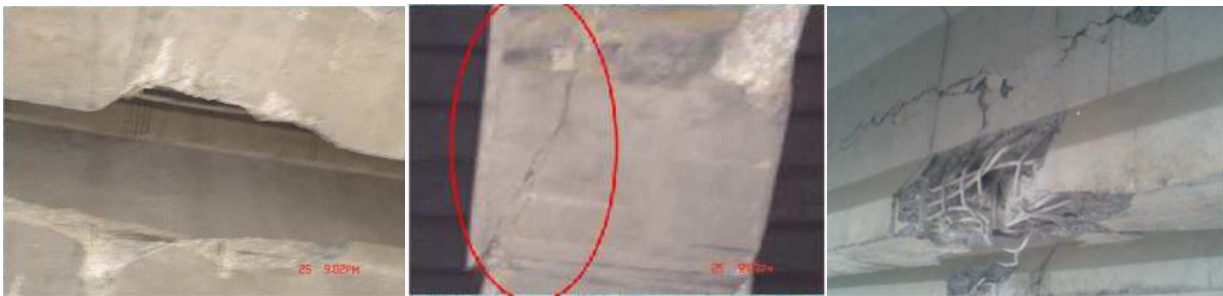
Figure I.1: Les diverses altérations engendrées par l'impact
