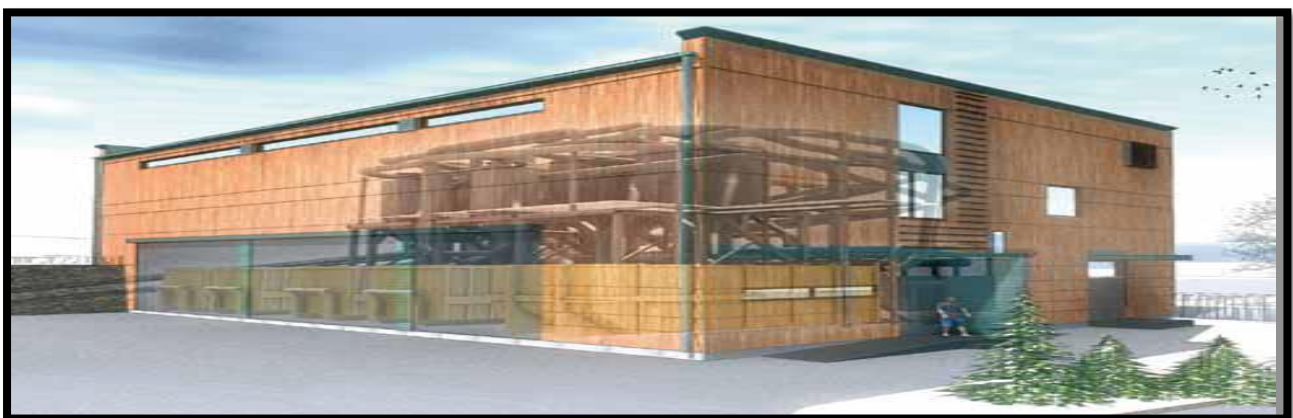
Figure n° 07 – le terminal de collecte/source : http://fr.wikipedia.org .
