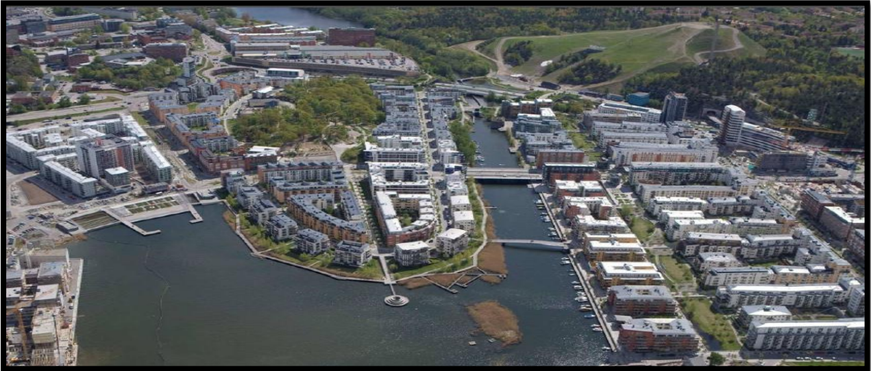
Image N°01 : Vue aérienne sur le quartier hammarby sjostad / source : www.hammarbysjostad.se
